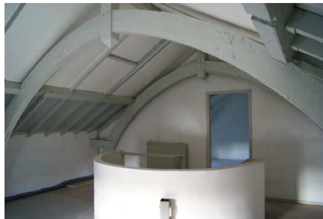
39. Origineel spant op zolder zichtbaar.
