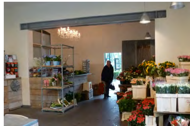
40. Doorbraak tussen winkel en wachtruimte, mogelijk door stalen balk.
