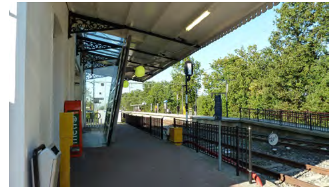
21. Perron 1 is niet langer in gebruik, 2012
