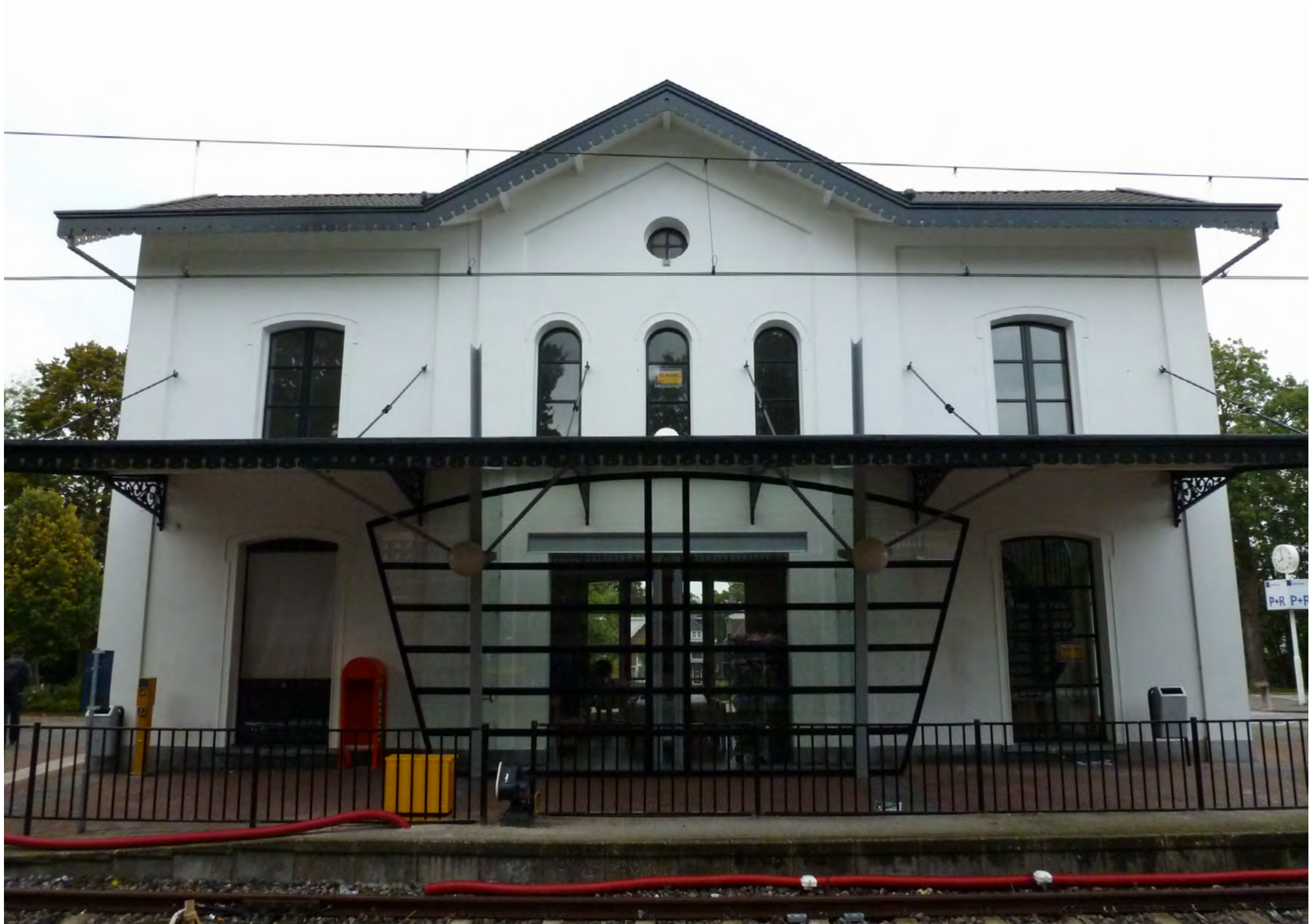
32. Spoorzijde station Wolvega met glazen scherm onder de luifel.
