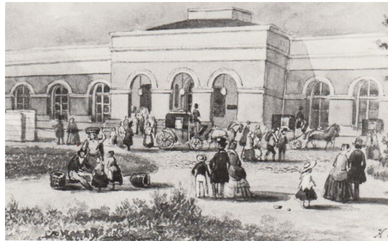
In de stationsbouw bleek Durands 'blokkendoos'-benadering al vroeg bruikbaar, zoals de oude stations van Haarlem (1841) en Leiden (1842) laten zien, voor de HJSM ontworpen door ingenieur F.W. Conrad. Beelden respectievelijk uit 1845 en 1848. [Stationsweb]
