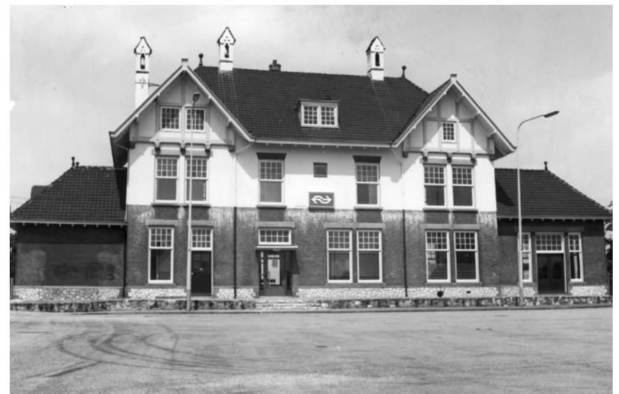
Afb. 4.5 Het station in 1970. Links de goederenvleugel met dichtgemetselde deuropening. Foto 28-07-1970. Beeldbank HUA, cat.nr 150798.
