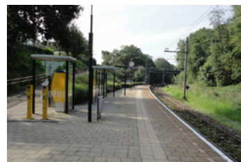
Chevremont (1930, treinhalte, haltegebouw uit 1960 gesloopt)
