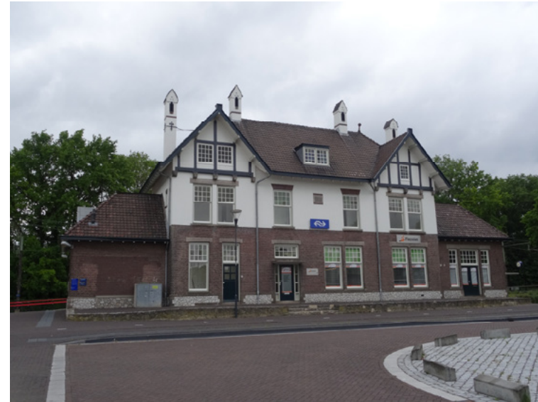
Afb. 5.8 De voorzijde (zuidgevel) van station Voerendaal.
