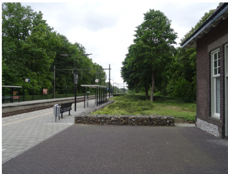
Afb. 4.9 De scheiding tussen perron en pleintje bij het gebouw, in bestrating en tussen perron en plantsoen met schanskorven. Op de achtergrond de haag tussen plantsoen en moestuin.
