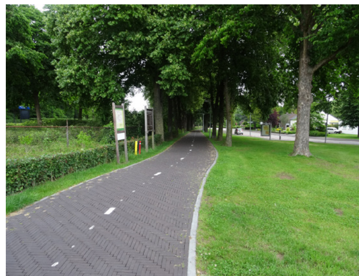
Afb. 3.13 De oostelijke Parallelweg als fiets/ voetpad vanaf het station naar het noordoosten. Aan het eind van de helling takt het pad aan op de Hoolstraat. Gezien vanaf het station naar het oosten,
