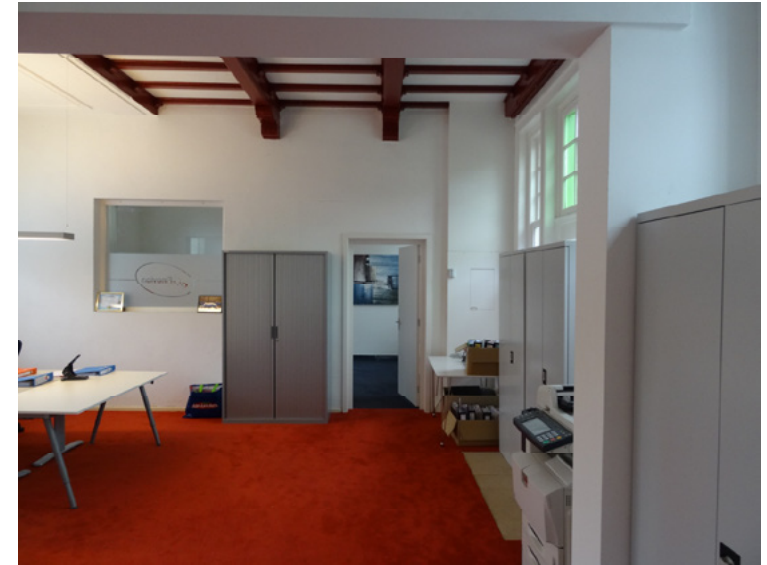
Afb. 5.19 De open kantoorruimte, over de grootte van de wachtkamers 2e en 3e Klasse. Middenrechts en boven is de doorbraak tussen de wachtkamers zichtbaar. De muren zijn ontdaan van de lambrisering. Rechtsachter de toegang vanuit de vestibule.
