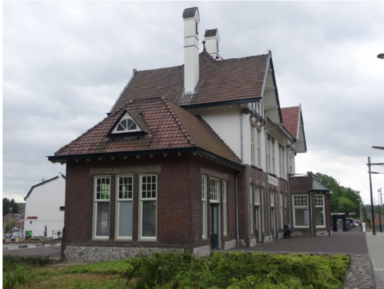
Afb. 5.10 De oostgevel van het station, met de aanbouw van de voormalige mijnwerkerswachtkamer.
