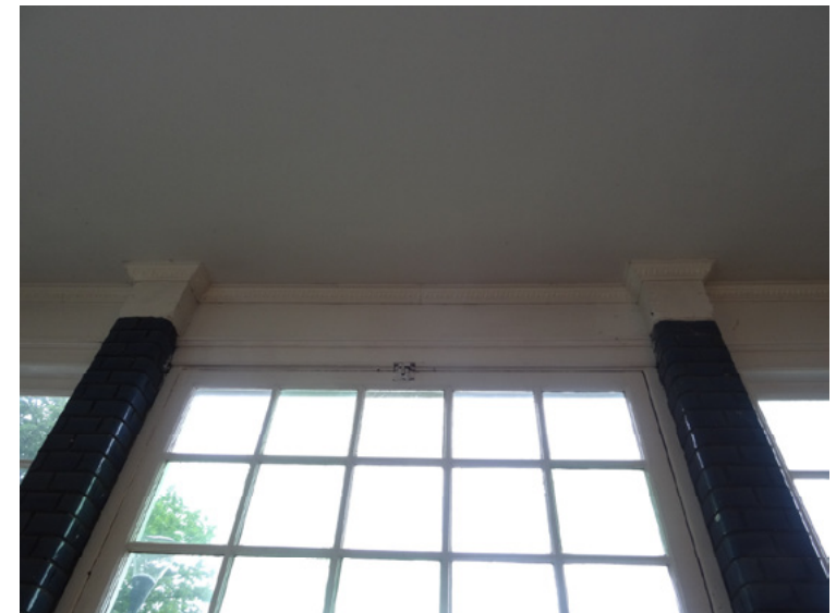
Afb. 5.20 De kolommen met blauw geglazuurde tegels, tussen de ramen aan de perronzijde.
