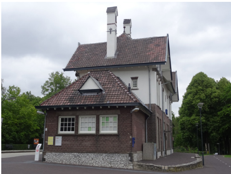
Afb. 5.11 De westgevel van het station, met de aanbouw van de voormalige goederenopslag. Het raam in de dakkapel is dichtgezet.
