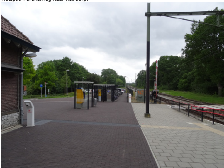
Afb. 4.12 De pleinruimte ten westen van het stationsgebouw. Rechts de spoorovergang naar het noordelijke perron. Links de vroegere goederenvleugel. Middenvoor de kaartautomaat en op de achtergrond de fietsenstalling en de parkeerplaats.
