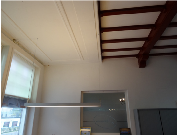
Afb. 5.21 De kantoorruimte heeft de originele plafonds. Hierin zijn herkenbaar; links met sierstucwerk de kleine gang naar de wachtkamer 3e klasse en rechts met balkenplafond de wachtkamer 2e klasse.
