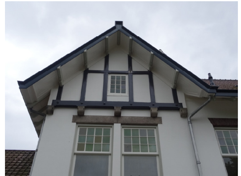
Afb. 5.14 De vakwerkconstructie rust op geornamenteerde granieten consoles. Daaronder een granieten latei op de eerste verdieping in de noordoostelijke topgevel.
