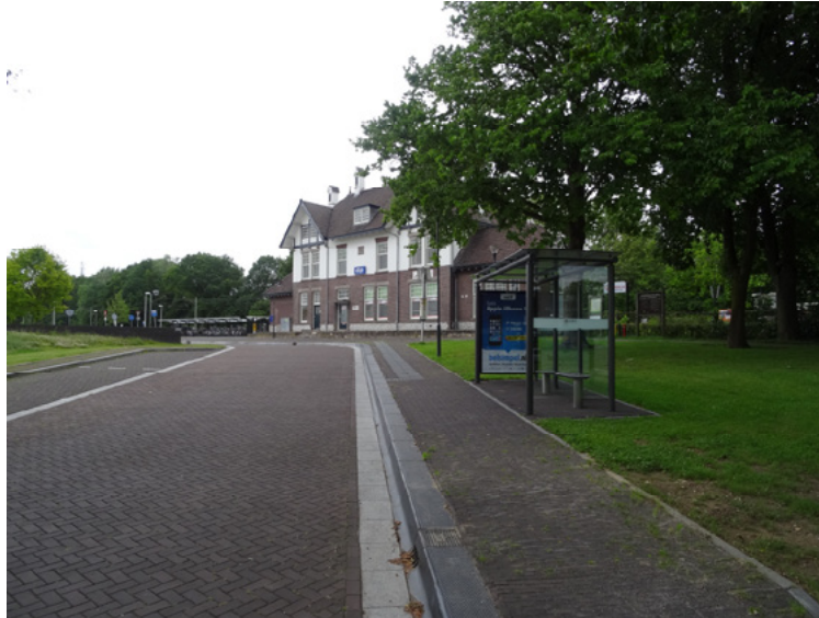
Afb. 4.15 De bushalte langs de oostelijke toegangsweg van het stationsplein.
