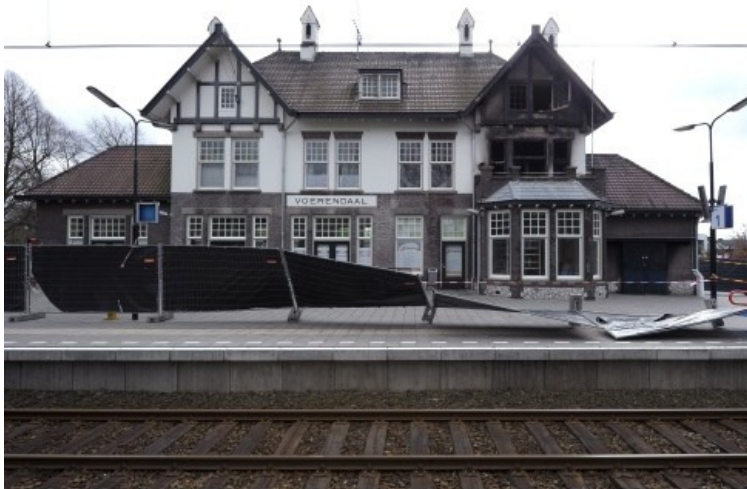
Afb. 2.6 De uitwendige brandschade aan het station, na de branden van 2 en 4 maart 2012.
