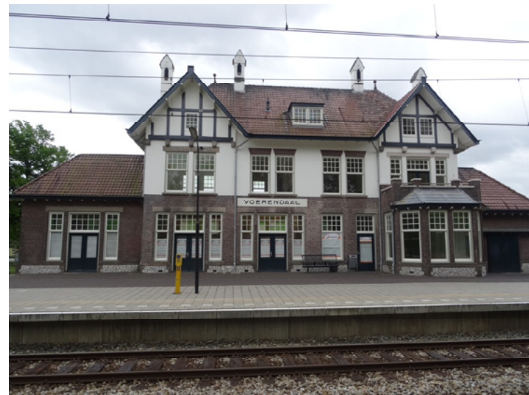
Afb. 5.9 De perronzijde (noordgevel) van het station, met rechts (westelijk) de serre-uitbouw van het plaatskaartenkantoor.
