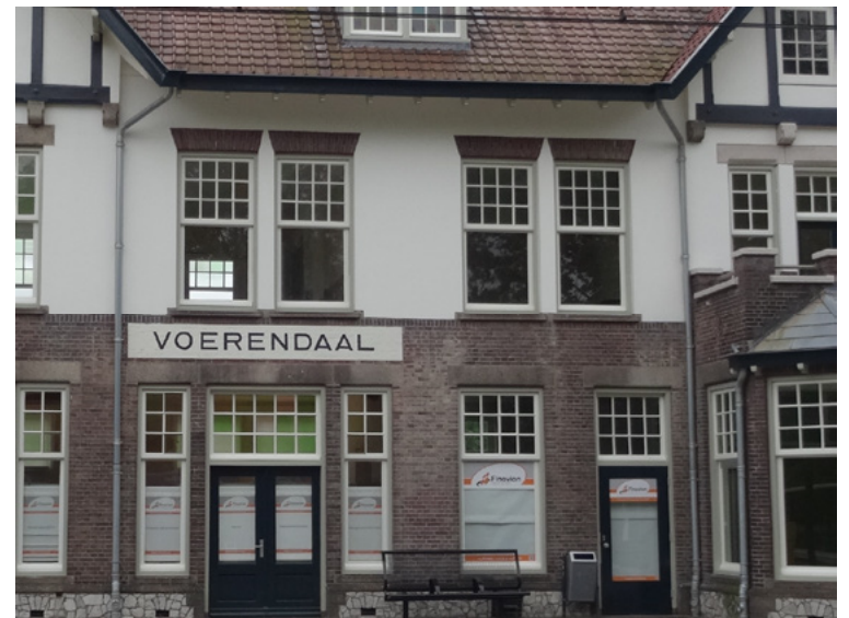
Afb. 5.15 Op de verdieping van het hoofdvolume hebben de raamopeningen een anderhalfsteens rollaag. Op de begane grond en in de topgevels zijn de granieten lateien zichtbaar.
