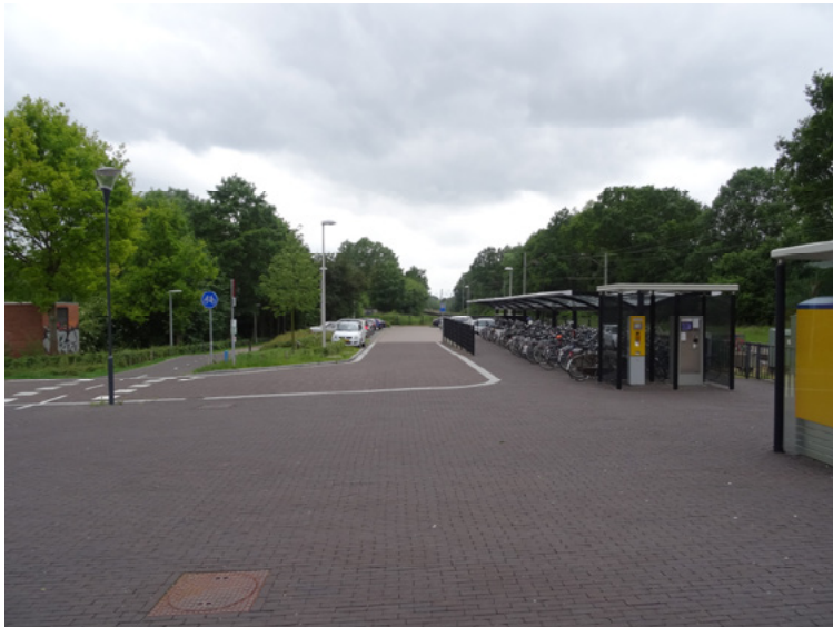
Afb. 4.11 De pleinruimte ten westen van het stationsgebouw. Rechts de kaartautomaat en op de achtergrond rechts de fietsenstalling en middenvoor de parkeerplaats. Links het fietspad Parallelweg naar het dorp.
