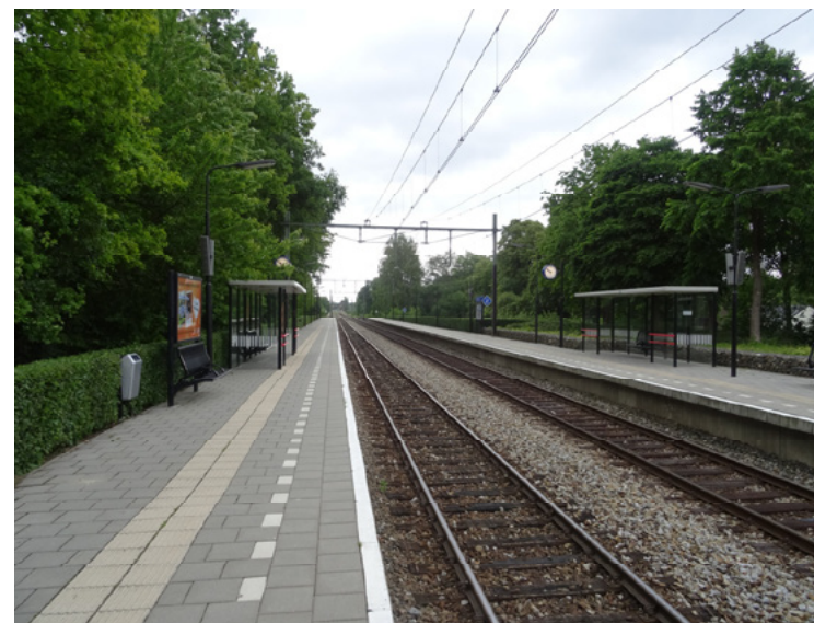
Afb. 4.10 De beide perrons gezien vanaf het noordelijke perron naar het oosten. Links achter het noordelijke perron de beukenhaag-afschieding.
