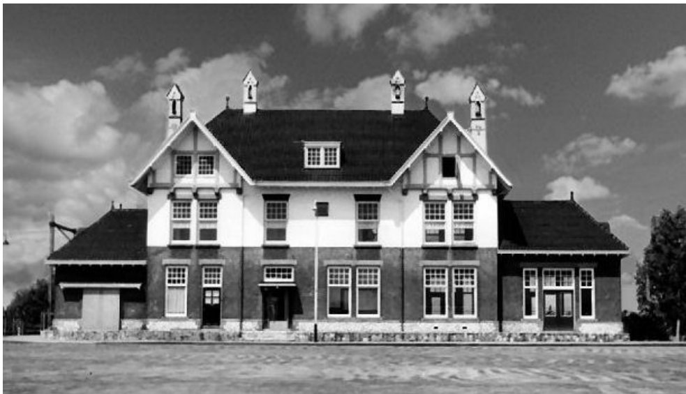
Afb. 4.4 Het station in 1965. Links de goederenvleugel met schuifdeuren. Bron; website Voerendaal vertelt.
