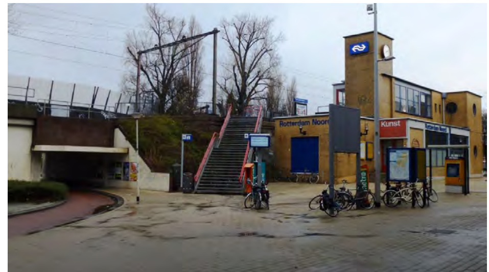
Afb: huidige situatie, rommelig, tegenstrijdige informatie over functie gebouw
