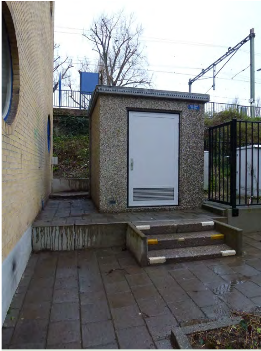
Afb: traforuimte tegen oostgevel
