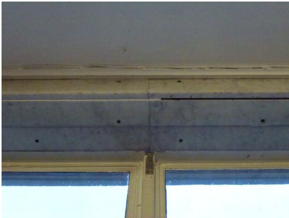
Afb: standaardaansluiting puien hal
