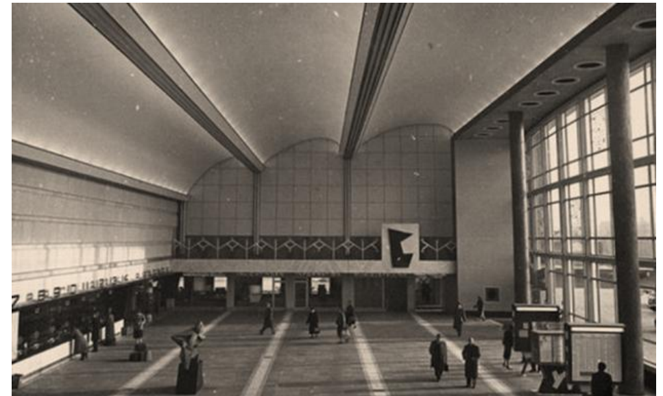
Afb stationshal Rotterdam Centraal
