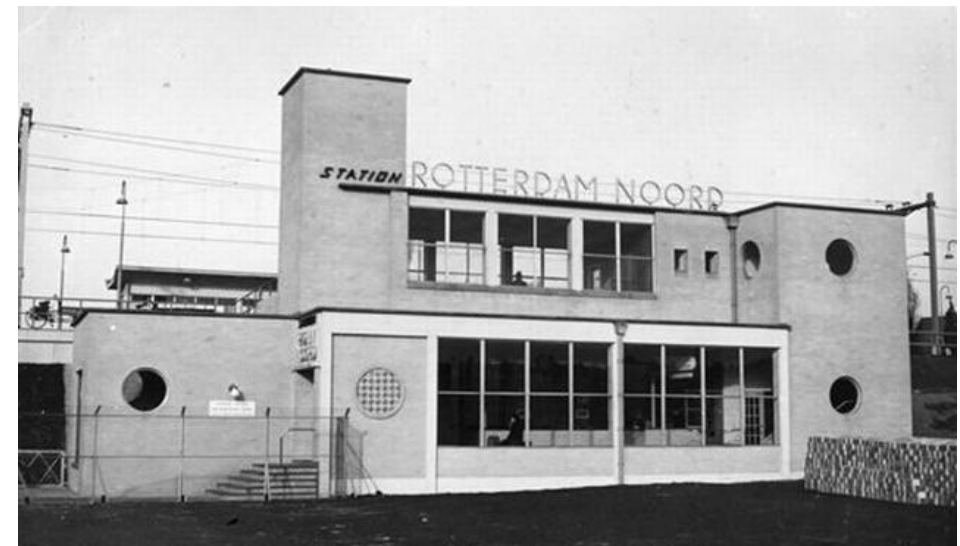
Afb: aanzicht gebouw zuidzijde
