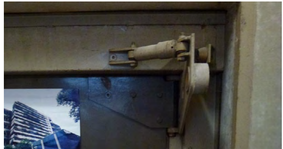
Afb: blik naar boven in de liftschacht
