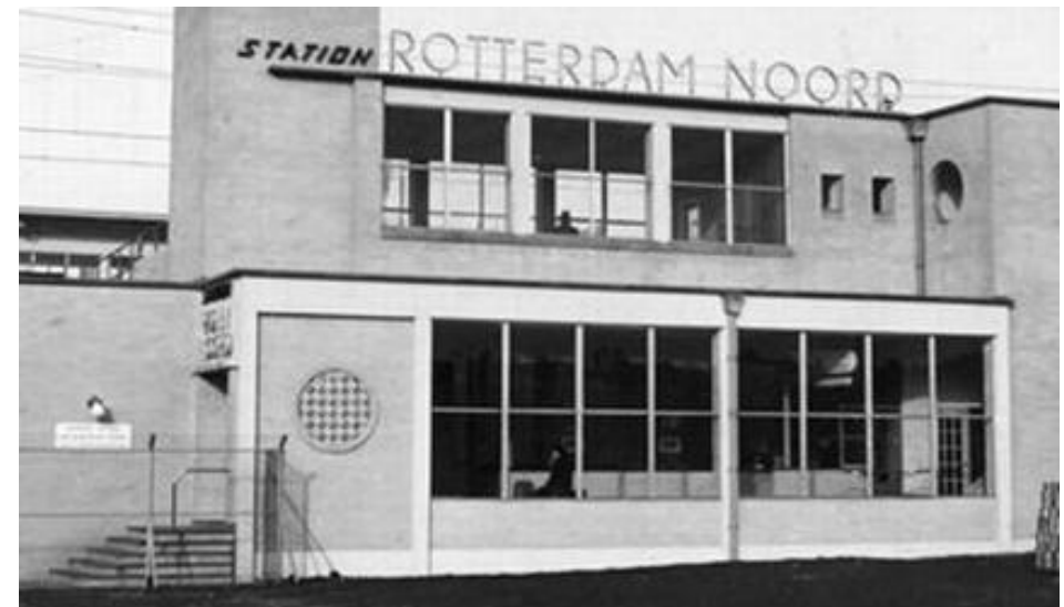
Afb: achter het glas is iets van de oorspronkelijke indeling te zien
