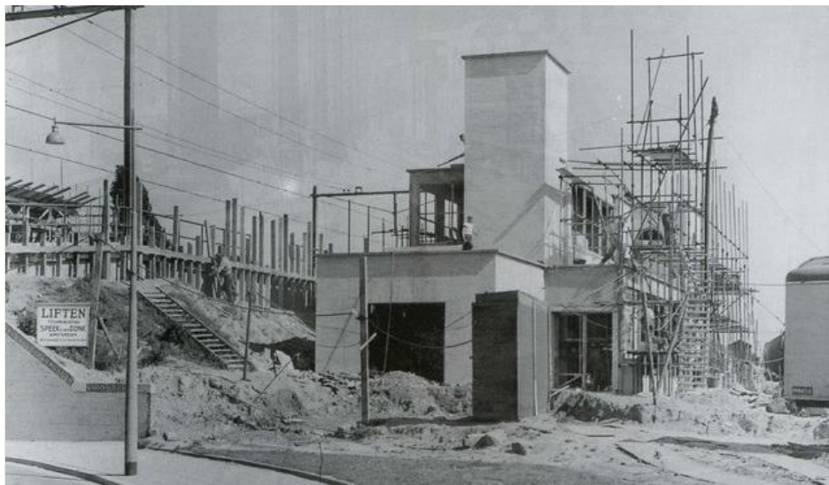
Afb: bouw van het zuidelijk gebouw
