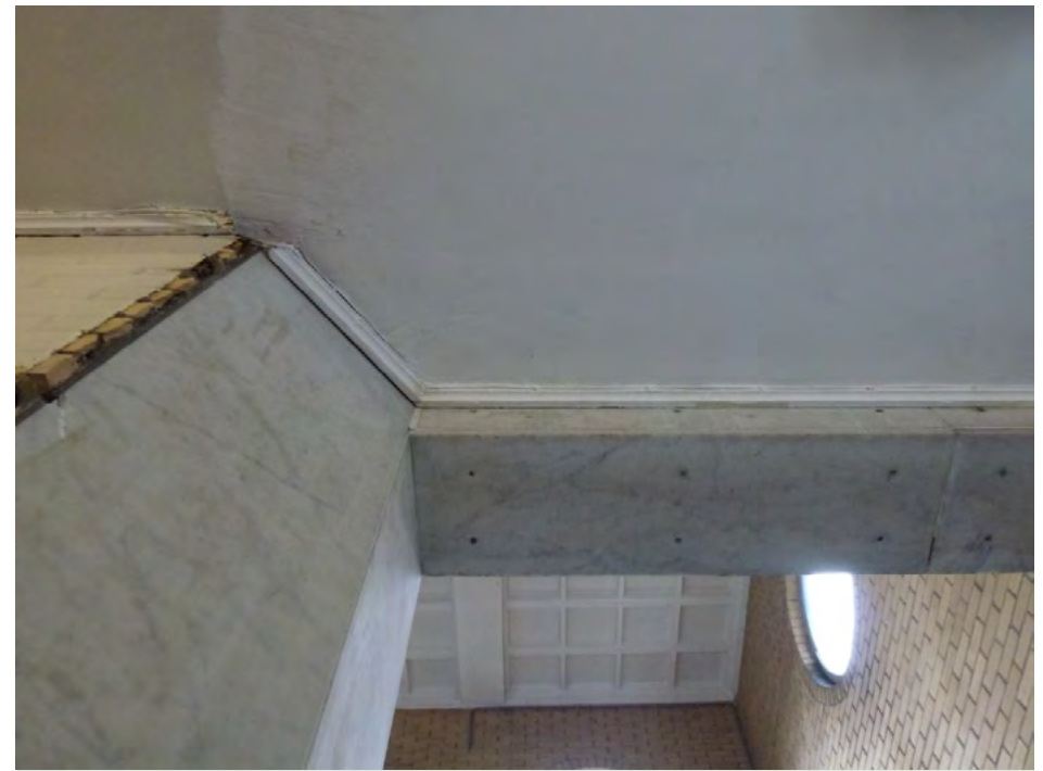
Afb: aansluiting hal op trappenhuis binnengevel
