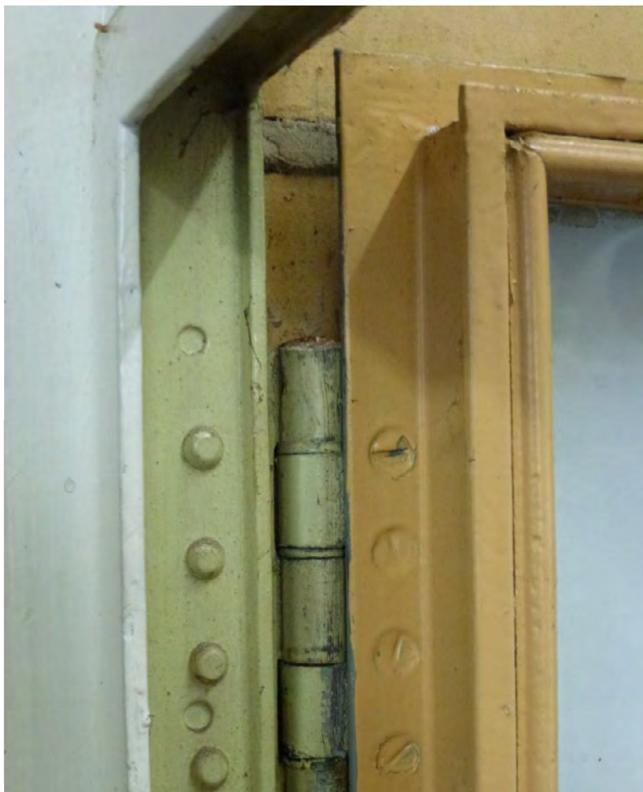
Afb: stoeltjesprofielen binnenkozijn, oorspronkelijk ook rond kaartverkoop.
