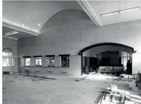
Afbouw van de door Van Ravesteyn ontworpen entreehal, v.l.n.r. de ramen naar de perrons, de loketten en de bagage inname onder de boog, 1949 (col. HUA)
