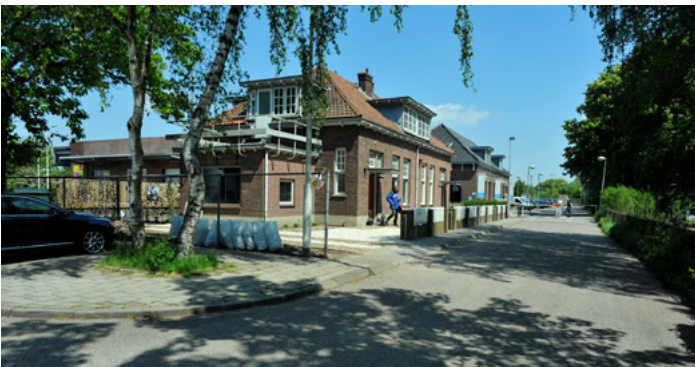
Voormalige dienstwoningen (32) aan de Spoorstraat, 2013
