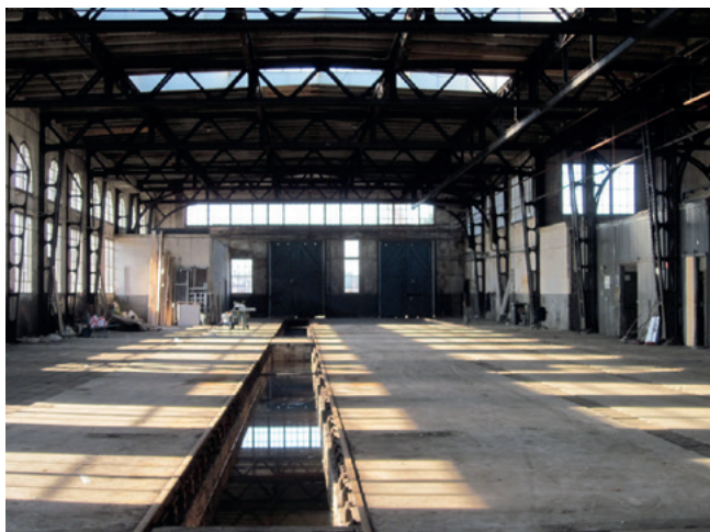
Interieur van de werkplaats, met de huidige werkkuilen in de vloer. Het interieur refereert ook door de werkkuilen nog aan het spoor karakter (2013)
