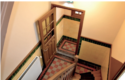
Gerestaureerde tochtportaal en trappenhuis van de voormalige dubbele woning aan de noordoostelijke kopgevel van het hoofgebouw, 2013
