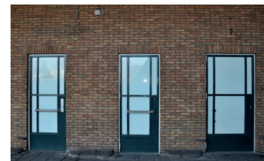
Dienstgebouw, stalen retiradedeuren met glas in de noordwest gevel, 2013
