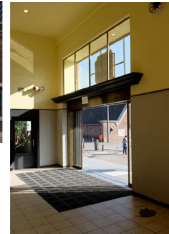
Stationshal, de entree deur met passende nieuwe glazen schuifdeur in bronzen profielen en de gereconstrueerde klok in het raam, okt. 2013
