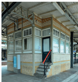
Voormalig perronseinhuis P (2) op het eilandperron, centraal gelegen tussen de trappen van de reizigerstunnel, Van Heukelom, 1907 (foto 2013)
