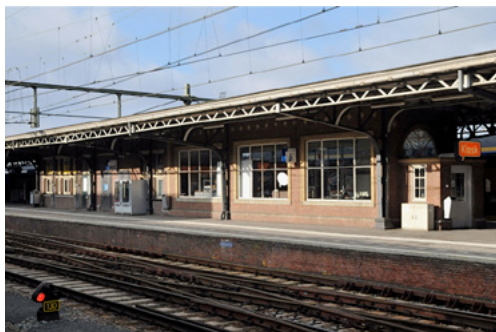
Eilandperron met perrongebouw A (3), 2013
