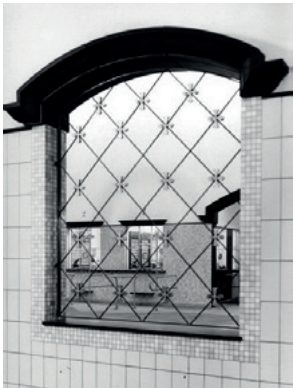
Opening in de wand tussen de uitgangsluis en de entreehal met zicht naar de loketten. Sierlijk smeedwerk en omlijsting door zwart stenen boog en mozaïektegels, 1950 (collectie HUA)
