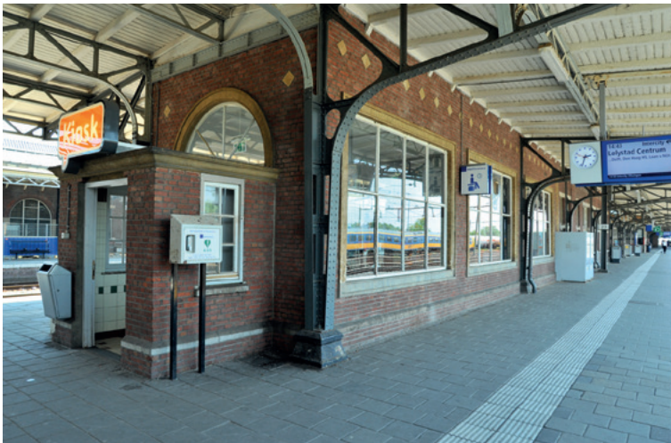
Gereconstrueerde entree van de voormalige wachtruimte aan de noordoostzijde, nu entree van de stationskiosk perron 2/3. Opvallend zijn de halfronde ramen in de kopgevel en de kloeke omrande glaspartijen. Het verbouwingsplan is toegeschreven aan Van Ravesteyn 1945-1949, foto 2013
