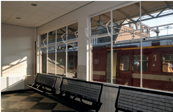
Interieur met diagonaal gelegde vloertegels, metalen kiepramen, recent verlaagd plafond en zwarte draadstalen banken, 2013
