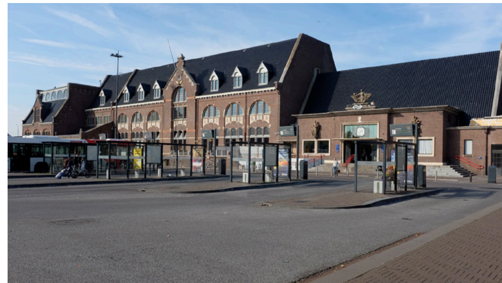
Vaardige en dienstige inpassing hal Van Ravesteyn in het hoofdgebouw van Station Roosendaal, oktober 2013.
