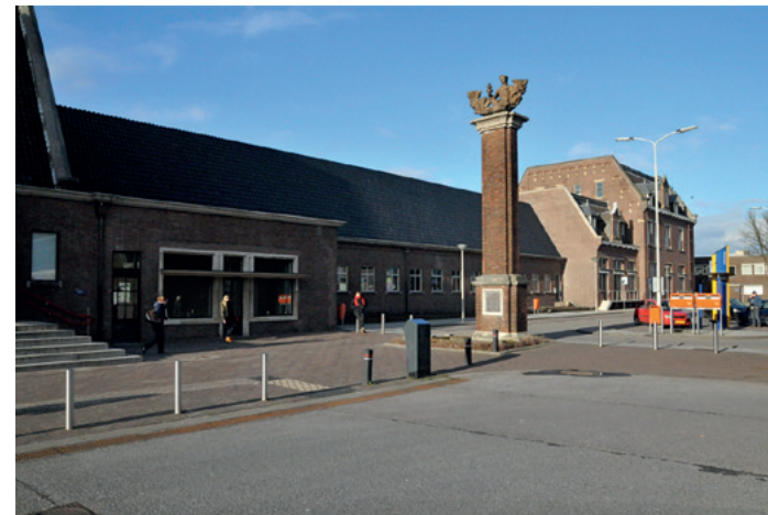
Het lineaire dienstgedeelte ten noordoosten van de entreehal, uit de bouwperiode Van Ravesteyn, met het eindstuk (rechts) uit de bouwperiode Van Heukelom 2013.
