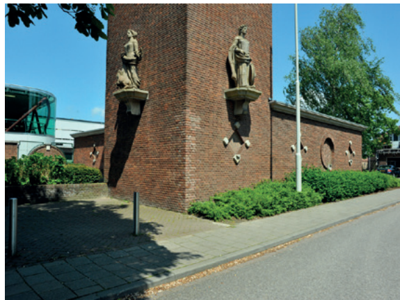
De toren van het ketelhuis op de hoek van het Stationsplein en de voormalige losstraat, nu Spoorstraat. Langs het ketelhuis ligt een groenstrook. Zichtbaar zijn de sporen van de verwijderde siermuur, 2013.
