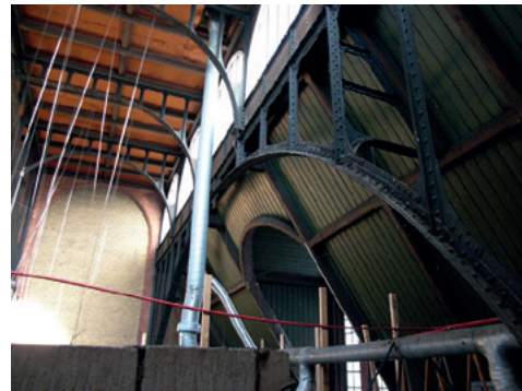
De kap van de visitatiehal, waaronder het verlaagde eindspant, is kenmerkend voor de bouwperiode Van Heukelom. Dit spant draagt de boogvormige ramen en de dwarspanten. In het midden van het eindspant bevindt zich de monumentale dakkapel, 2013.
