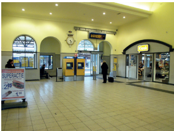
Wijzigingen in bouwperiode 3 Stationshal richting perrons, v.l.n.r. de dichtgezette oorspronkelijke doorgang, drie nieuwe doorgangen op de plaats van de oorspronkelijke ramen, de originele klok en een recent toegevoegde tweede boog, 2013
