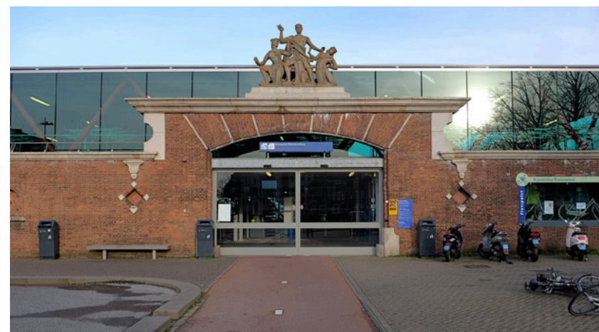
Monumentale poort met verhoogd middenstuk, geprofileerde kroonlijst en beeldengroep. Achter de siermuur bevindt zich de nieuwe fietsenstalling, 2013
