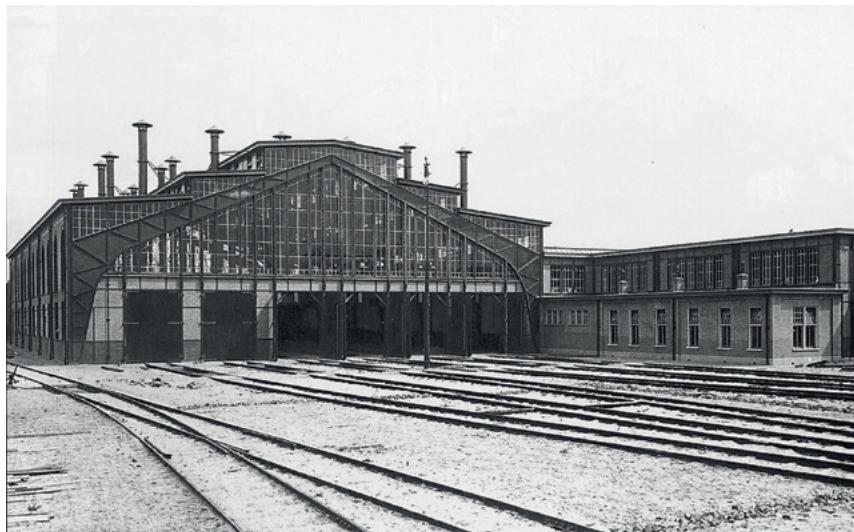
De Locomotievenloods, met de opstelplaats (links) en werkplaats met platte afdekking (rechts). Voor treinreizigers is de locomotievenloods langs het spoor goed zichtbaar (Broos, 2004, p. 83)
