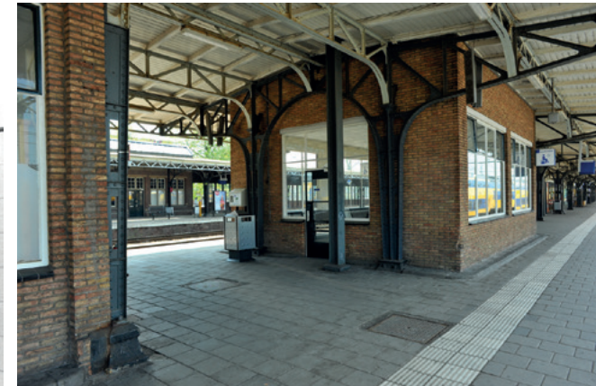
Wachtruimte Beneluxreizigers op het eilandperron, gebouwd als wachtruimte voor internationale reizigers in 1957, (foto 2013)
