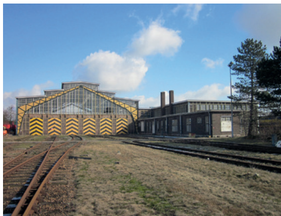
Front van de Locomotievenloods. Op het dak zijn de ontluchtingskanalen van de rookkappen verwijderd. Rechts de kantorenvleugel, 2013
