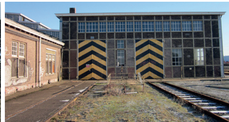
Front van de werkplaats, na de gevelrestauratie (2013)
