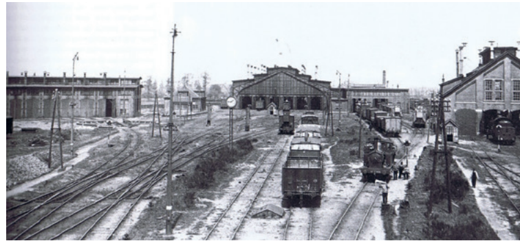
Overzicht van het tractieterrein, met van links naar rechts: polygonale locomotievenloods, tractiegebouw en twee rechthoekige locomotievenloodsen (nog aanwezig, 16), (foto 1924, Broos, p.81)
