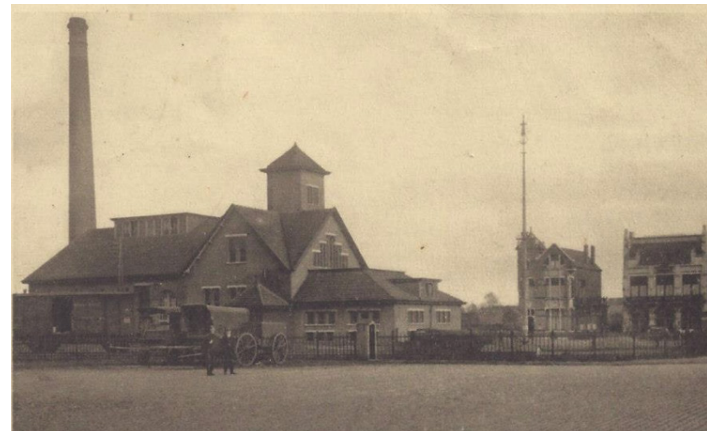
Machinegebouw tegenover het station, circa 1915 (col. I. van Strien)
