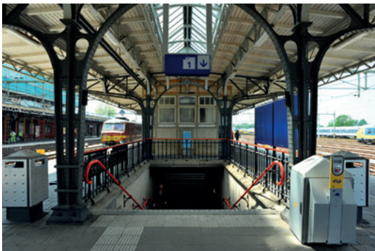
Zicht op de perronopzichtersruimte, lichtkap en traggat van de reizigerstunnel. Storen is het verspreid geplaatste perronmeubilair, 2013
