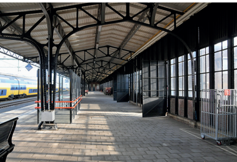
Perronoverkapping en perronwand van perron 1, tussen hoofdgebouw en gebouw staf, 2013
