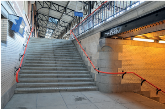
De strategische geplaatste personentunnel (2013)
