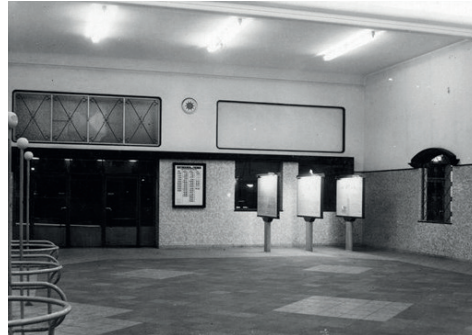
Entreehal met zicht naar de ingang. Te zien zijn ondermeer de hekken voor de loketten (links), de ingang met kruizen in de bovenramen, het afdekornament van een luidspreker in het midden van de voorgevelwand, het reclamebord met ronde hoeken, de borden met vertrek- en aankomsttijden, en het diagonale patroon in de vloertegels, 1950 (collectie HUA)
