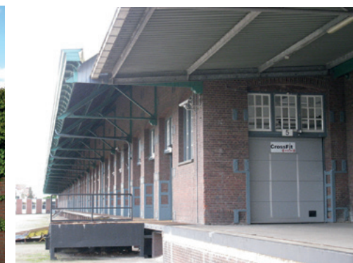
Douanegoederenloods aan de Spoorstraatzijde met overdekt betonnen laad- en losperron, 2013
