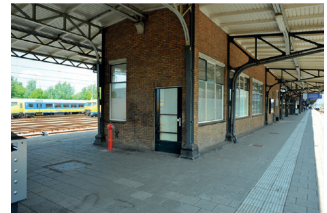
Herbouw van na de Tweede Wereldoorlog van de voormalige openbare retirades en dienstgebouw, nu uitsluitend dienstgebouw. Gezien vanuit het zuiden. Architect onbekend, 2013
