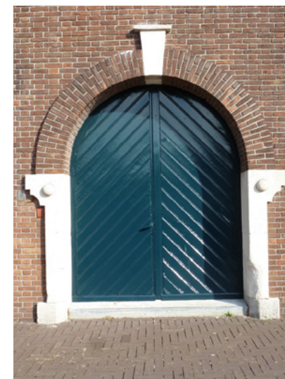
Detail poort scooterberging, met slijtvaste stenen omrandingen, 2013
