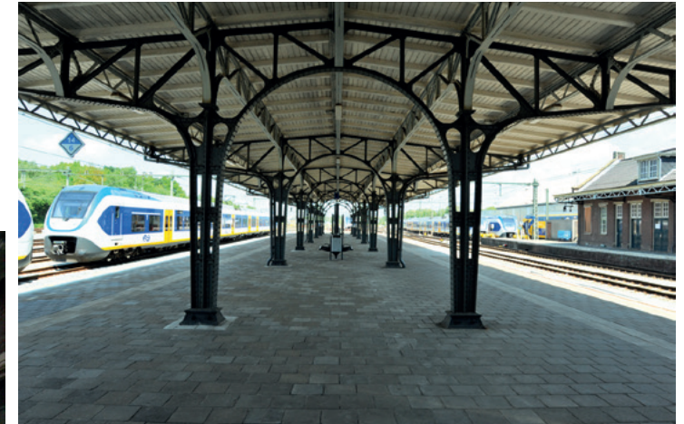
Noordelijke uiteinde van perron twee met uitzicht op het grootse emplacement. De overkapping zoneert het perron in de lengterichting in drieën. Het contrast tussen het donker geschilderde staal en het licht geschilderde houten dakbeschoot, doet de constructieve samenstelling goed uitkomen, 2013
