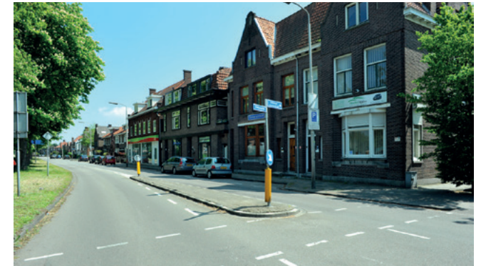
Eenzijdige bebouwing Spoorstraat hoek Admiraal Lonckestraat (2013)
