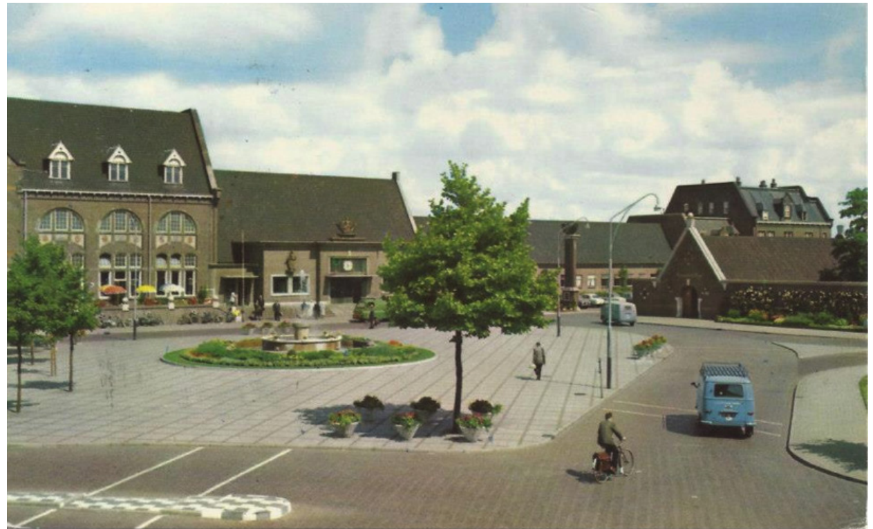
De zorgvuldige detaillering van de pleininrichting, diagonale bestrating, plantenbakken, fontein in het groen, verhoogd terras voor het station en een plantenstrook voor de siermuur, circa 1955 (col. DB)
