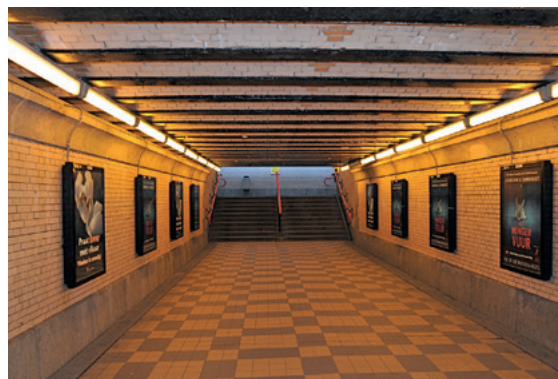
Zicht door de tunnel. Het plafond van de tunnel is gemaakt met profielbalken met daartussen bakstenen booggewelven, 2013
