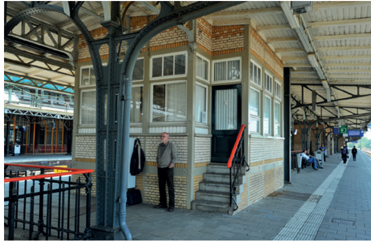
Perronopzichtersruimte, voormalig perronseinhuis, het opschrift Rosendaal is verdwenen, 2013
