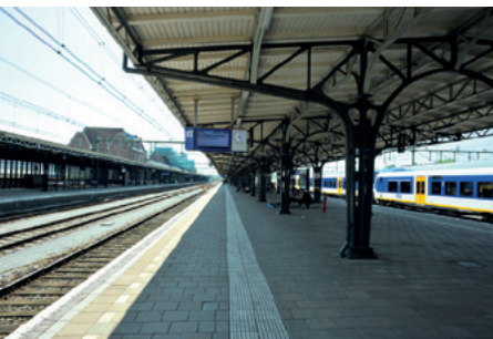
Het lange eilandperron, tussen spoor 3 en 4, gekeken richting perron 1 en het hoofdgebouw (foto 2013)
