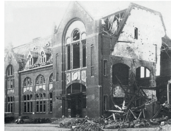
Het puin van het beschadigde middendeel van het stationsgebouw is begin 1946 verwijderd. De perronmuur is gedeeltelijk behouden gebleven. (Broos, 2004, p. 159)
