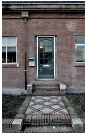
Van Ravesteyn maakte de overgang in bouwperiodes zichtbaar. Overgang geblokt ornament van Van Heukelom in een ruitvormig ornament van Van Ravesteyn, in de gevel van perrongebouw A (3). De verticale siersteen markeert de grens. 2013
