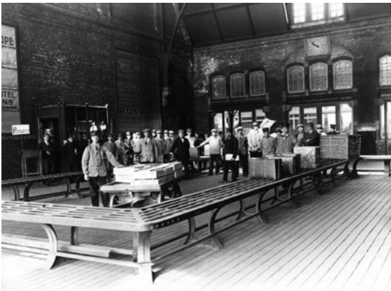
Controle van internationale reizigers vond plaats in de imposante visitatiezaal. In de wand, aan de zijde van de perrons, onder de monumentale dakkapel, bevindt zich één van de vele klokken, circa 1920. (col. HUA)
