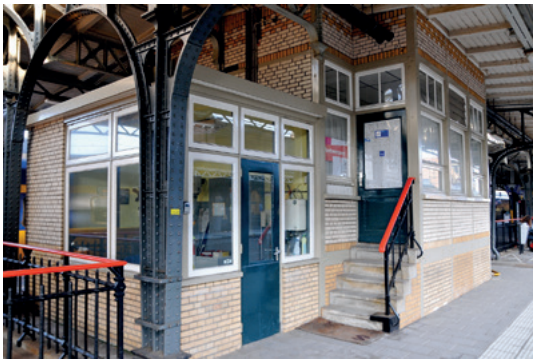
Late verstorende aanbouw aan het perronseinhuis, 2013
