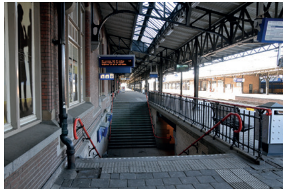
Lichtkappen ter plaatse van de personentunnel, 2013
