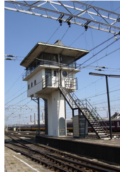
Seinhuis bij Station Maastricht, Van Ravesteyn 1933. (foto K. Vermaas)
