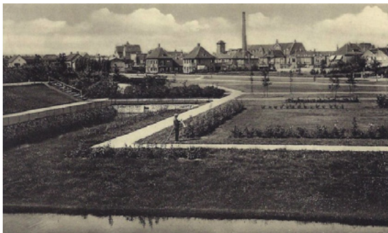
Burgemeester Coenenpark gekeken richting machinegebouw en station. De Parklaan is pas gedeeltelijk bebouwd, circa 1935 (col. I. van Strien)
