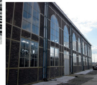
De langsgewel van de stallingsloods met de kenmerkende reeks boogvensters, na de restauratie (2013)
