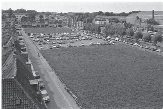
Na sloop van de Beijnes-fabriek en de rest van het blok, lag er lange tijd een open ruimte voor het station (in de rechterbovenhoek)
