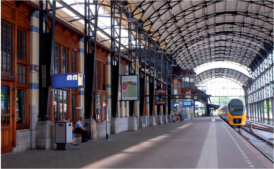
De kapconstructie, ontworpen door H.W.M. Werker
