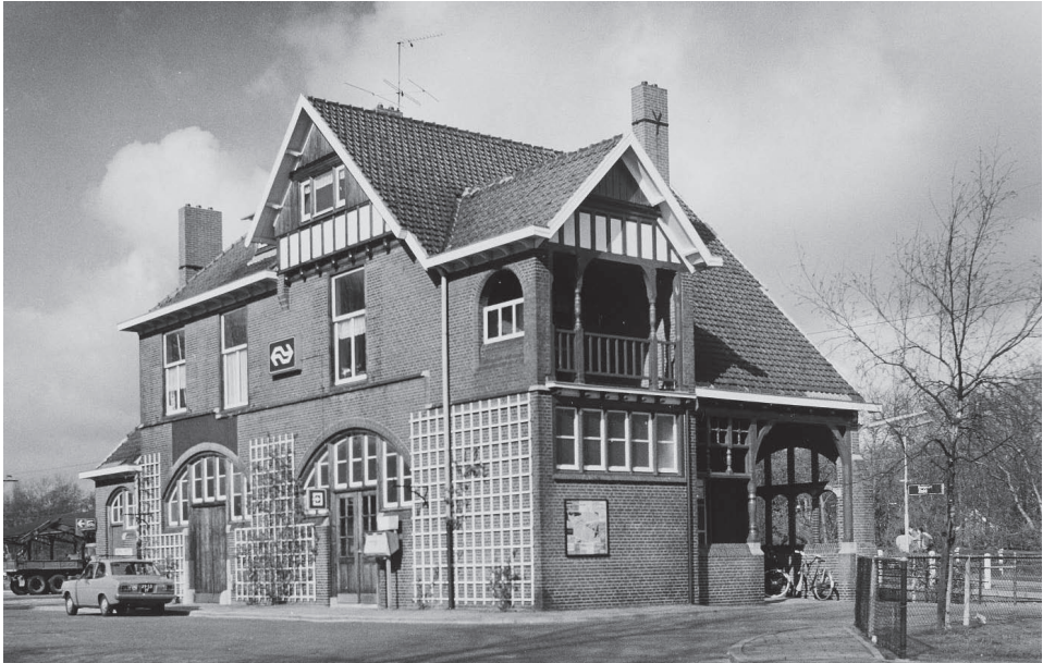
Station Santpoort Zuid, 1898
