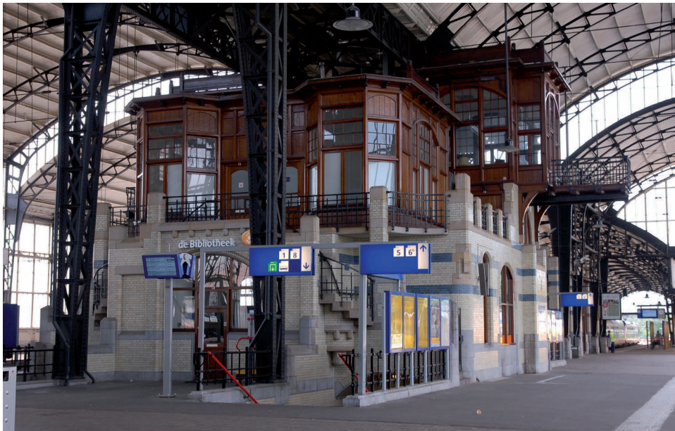
gebouw D, Seinhuus
