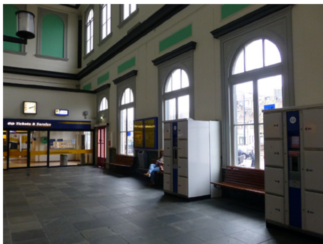
Extra ruimten aan weerszijden van de hal en plaatsing kluisjes doen afbreuk aan de oorspronkelijke ruimtelijkheid.
