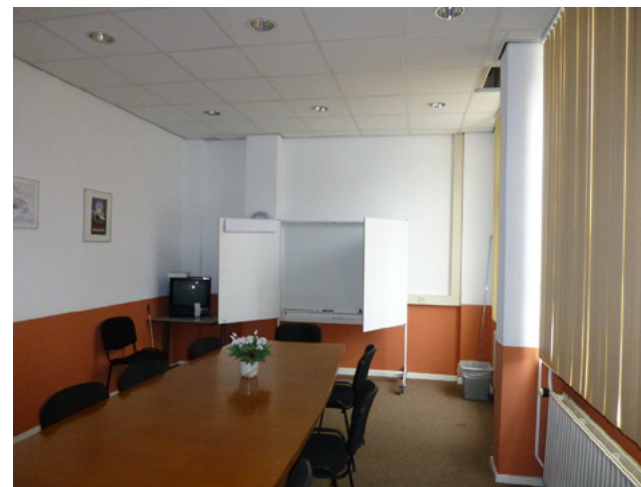
Vrijwel overal zijn verlaagde plafonds ingehangen, waardoor de oorspronkelijke hoogte niet meer te ervaren is.
