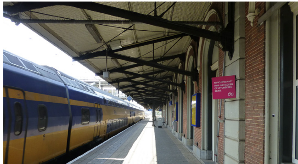
Eerste perron met originele marquise.
