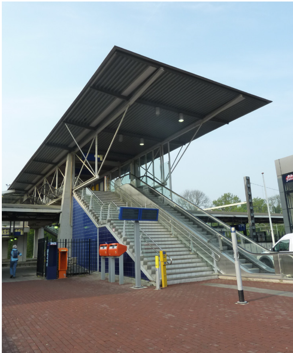
Sterk overkragende kap van de voetbrug.
