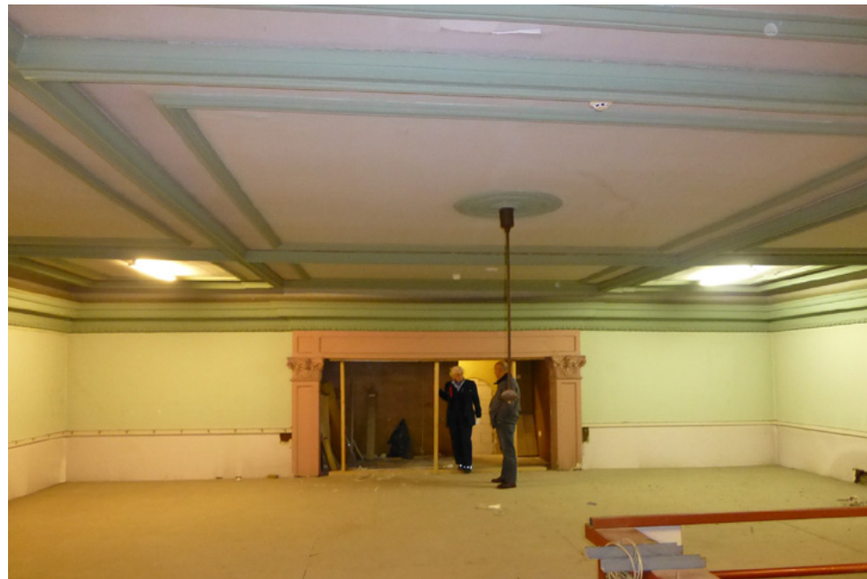
Boven het verlaagde pfafond van de voormalige wachtkamer 1e klasse is het originele plafond zichtbaar.
