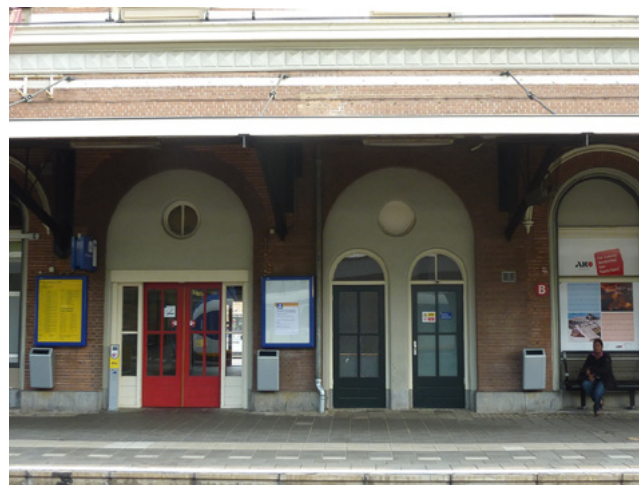
Een in 1960 afgebroken uitbouw is nog altijd herkenbaar aan het gebruik van nieuwere baksteen en de grotere gevelopeningen in de perrongevel.
