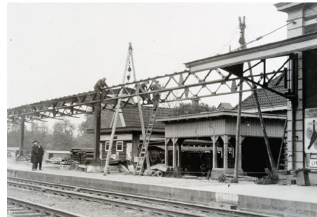
In 1933 kwam in het verlengde van de bestaande perronluifel een nieuwe perronkap. [DIEP]
