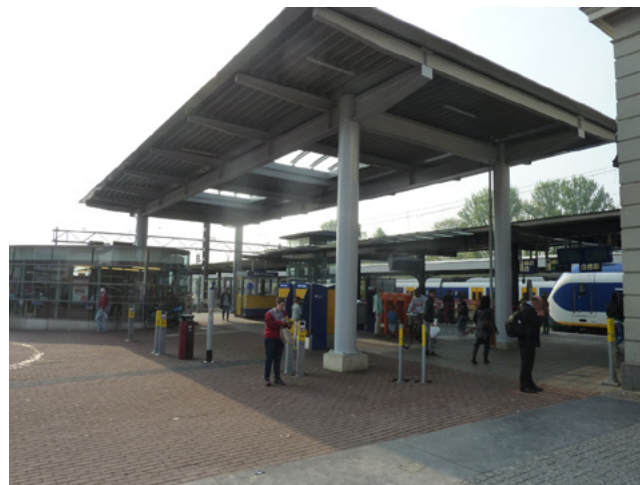
Vernieuwde droogloop uit 2010 aan de oostzijde van het stationsgebouw.
