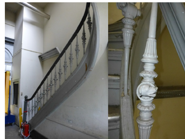
Zeer sporadisch originele interieurafwerkingen hier het trappenhuis.
