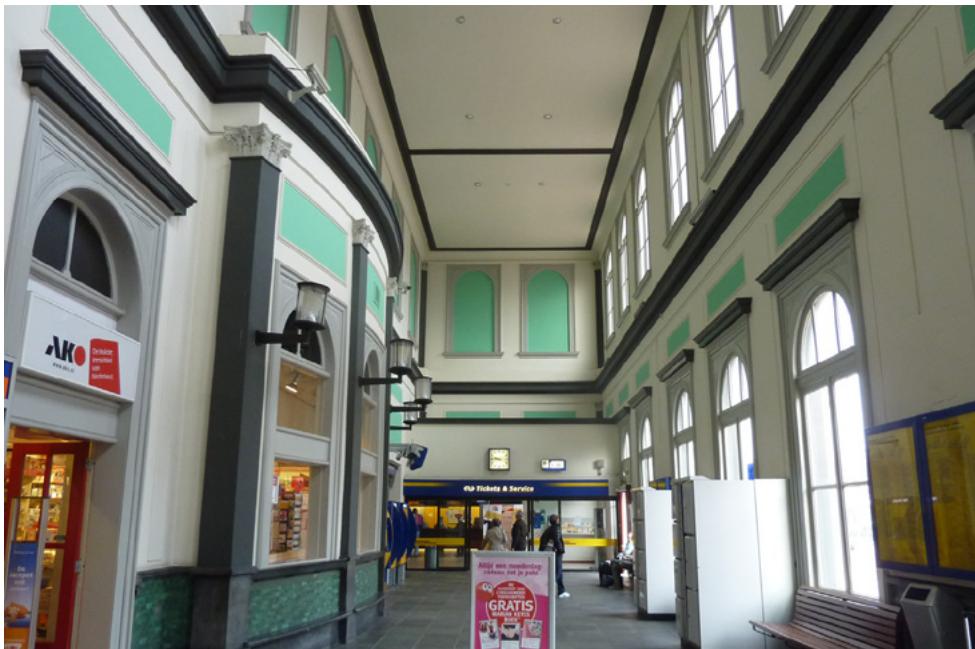
Dubbel hoge stationshal, de kleurstelling is niet origineel. Links de halfronde wand van het vm. plaatskaartenkantoor.
