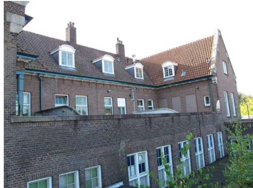
Overzicht achtergevel stationsgebouw in zuidwestelijke richting
