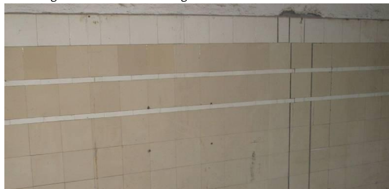
De oorspronkelijke betegelde wandafwerkingen van het personeelsverblijf zullen binnenkort achter voorzetwanden verdwijnen.
