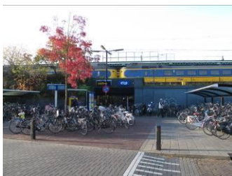
Nieuwe toegang Diepenveenseweg
