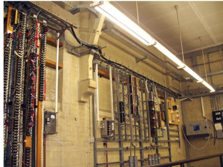
Het interieur van het ketelhuis, waar slechts de onderste delen van de kapconstructie zichtbaar zijn door een verlaagd plafond. Bron: Bouwhistorische verkenning BBA 2009.
