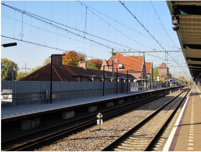
Overzicht van het tijdelijke perron en het stationsgebouw vanaf het eilandperron.
