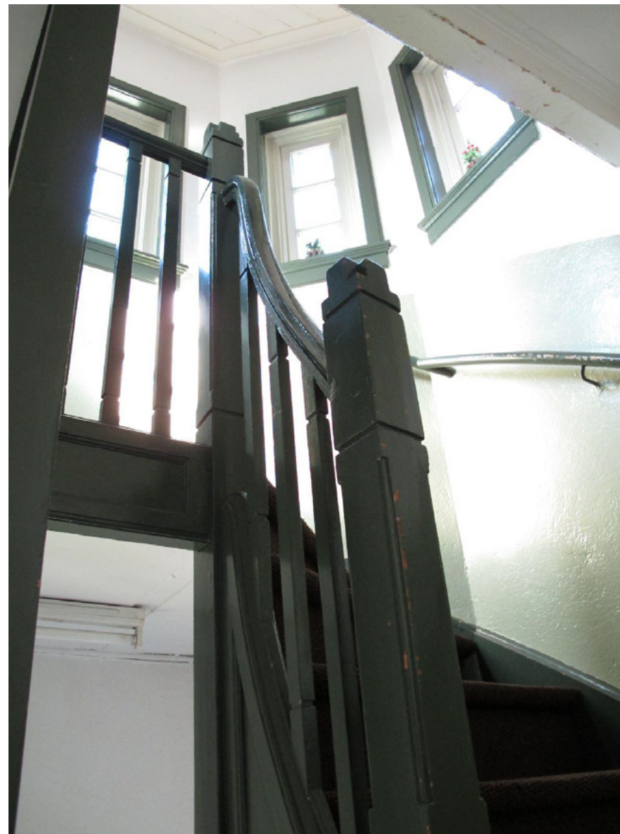
Interieur trappenhuis met oorspronkelijke vensteromlijstingen (nr. 7)
