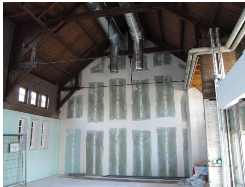
In afwachting van herbestemming casco gerenoveerde ruimte in goederenloods, met rechts nog een restant van een vroeger kantoor.
