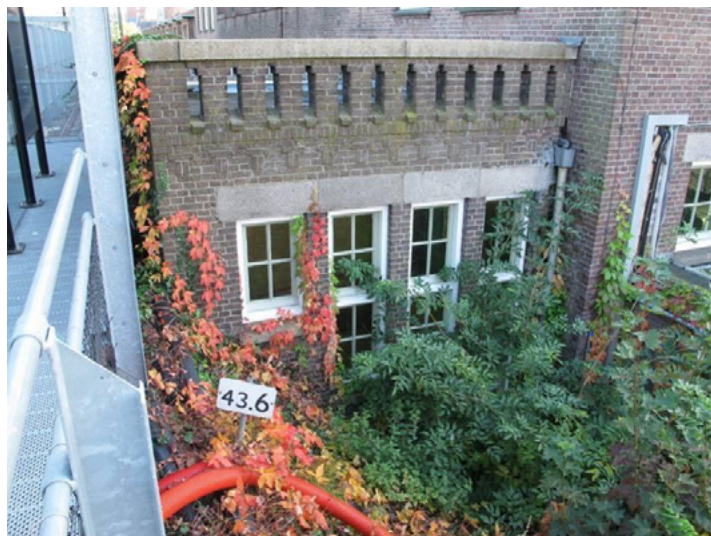
Het verbindingslid tussen de stationshal en de tunneltraverse.
