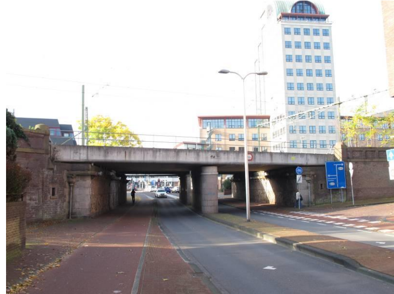
Viaduct ter hoogte van de Brinkgreverweg, met op de achtergrond kantorencomplex Leeuwenbrug.
