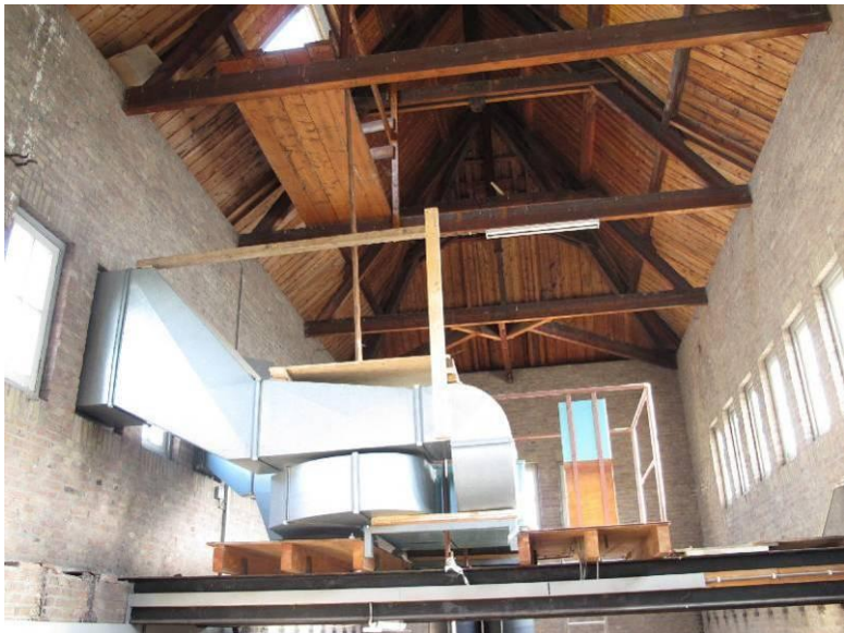
De ruimte waar zich oorspronkelijk twee waterbassins bevonden. Van de vroegere reeks stalen balken zijn nog slechts enkele balken bewaard.
