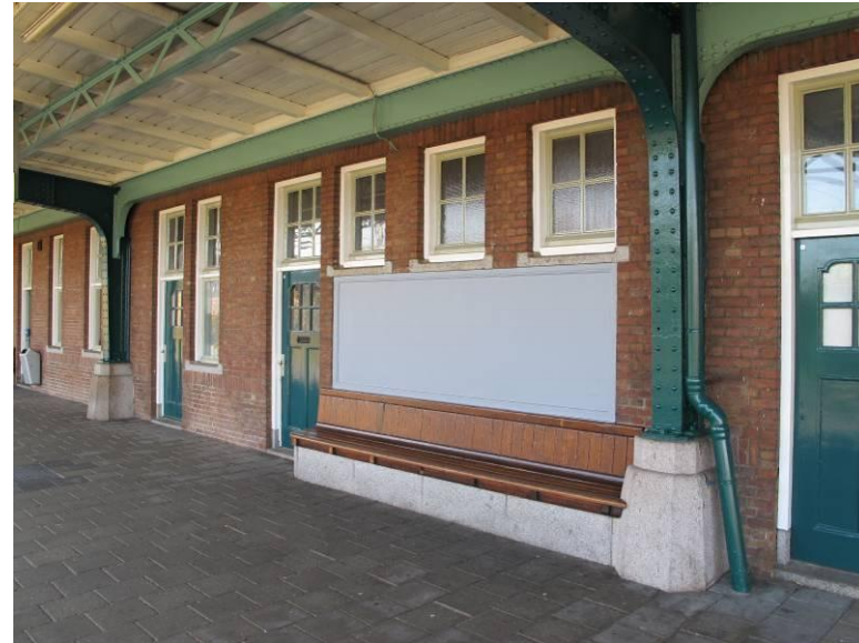
Bank en mededelingenbord tegen de noordgevel van het dienstgebouw.
