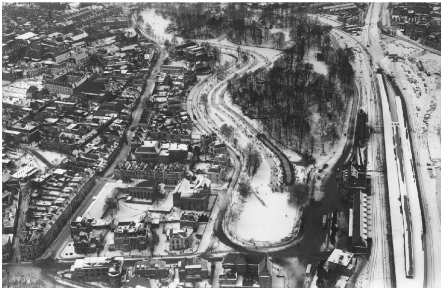
Luchtfoto uit 1947 met het station en de Singel. Nog altijd hebben zich geen grote wijzigingen in de structuur rond het Stationsplein voorgedaan (bron: Stadsarchief Deventer; (documentnummer: 1194_000347))
