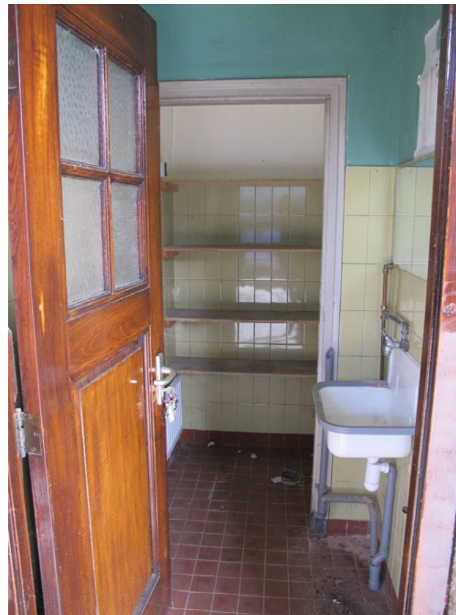
Impressie van het interieur van het toiletgebouw.
