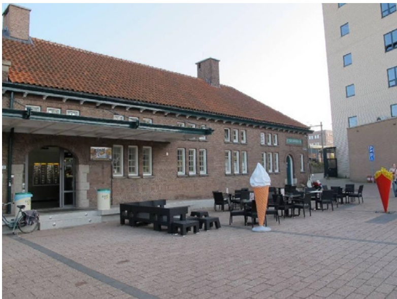
Overzicht oostzijde voorgevel van de voormalige rijwielstalling en goederenafdeling.
