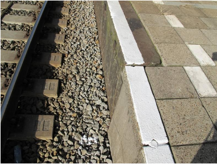
Aansluiting oorspronkelijke gemetselde perronwand op uitbreiding in beton aan de oostzijde.
