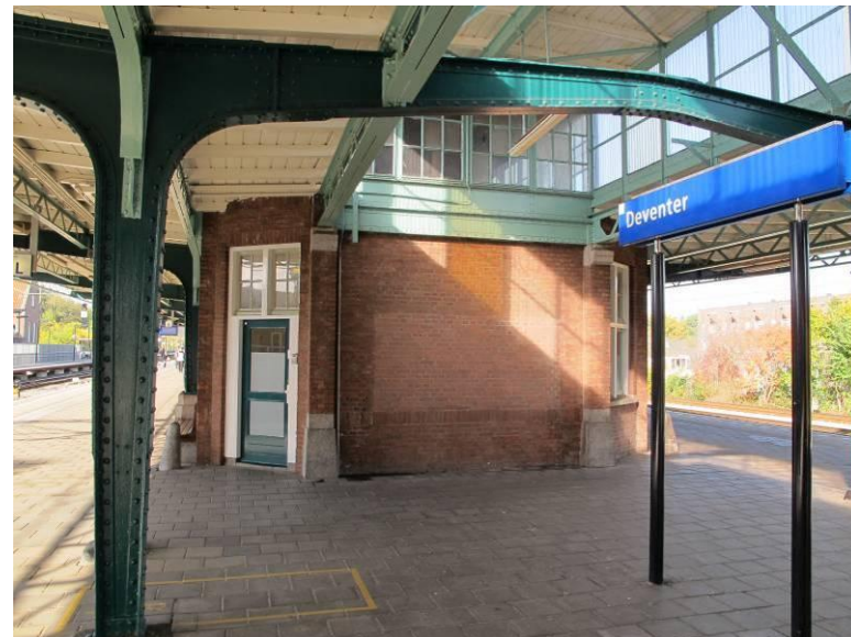
Oostelijke kopgevel van het dienstgebouw.
