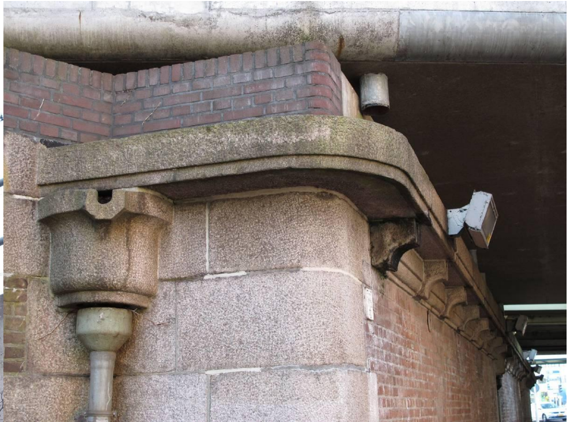
Detailering viaductwanden met consoles en waterspuwers in graniet.
