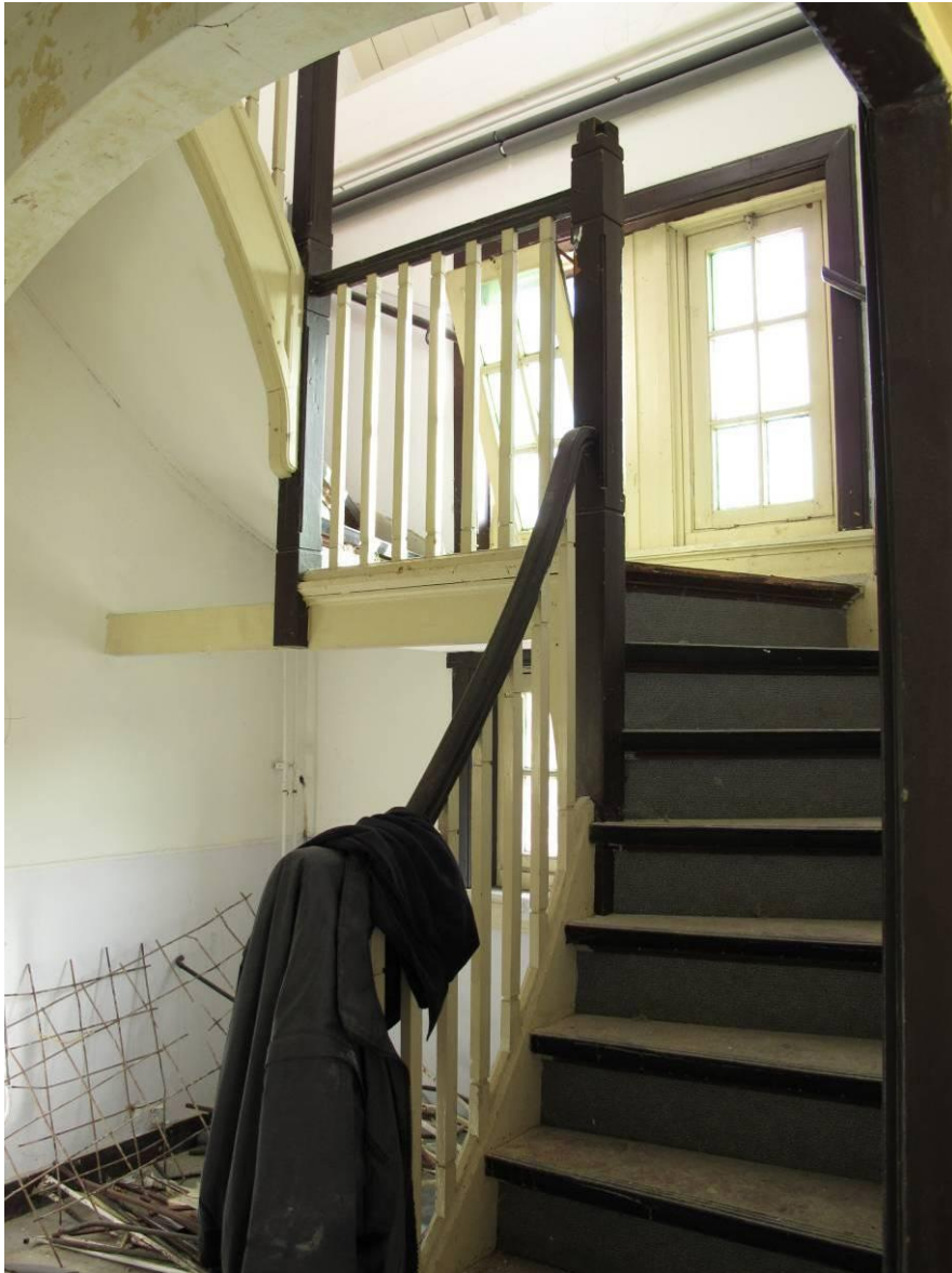
Separate trap naar de zolderverdieping (nr. 4)
