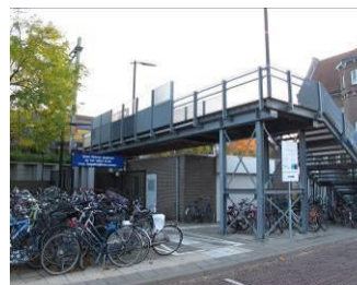
Aanleg nieuw (tijdelijk) perron
