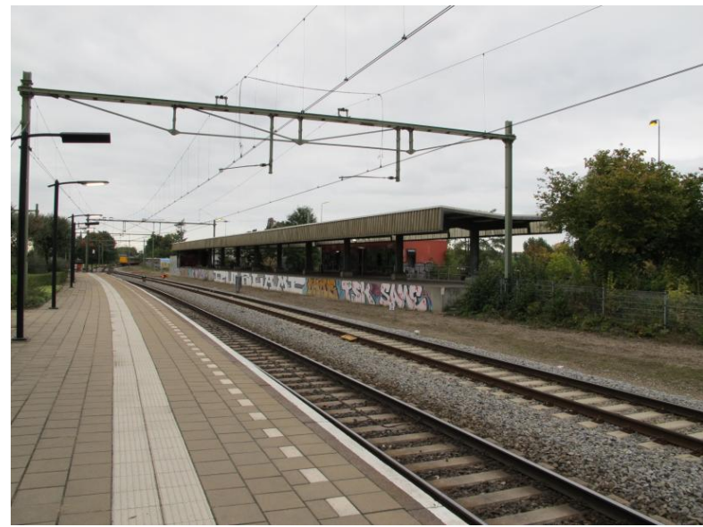
Overzicht van het postperron, gezien vanaf het eilandperron.
