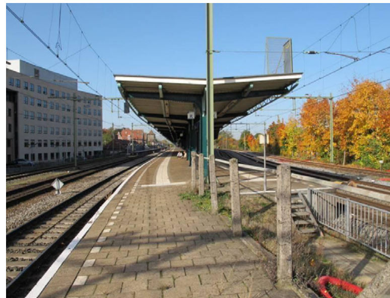
Oostelijk uiteinde van de perronoverkapping.
