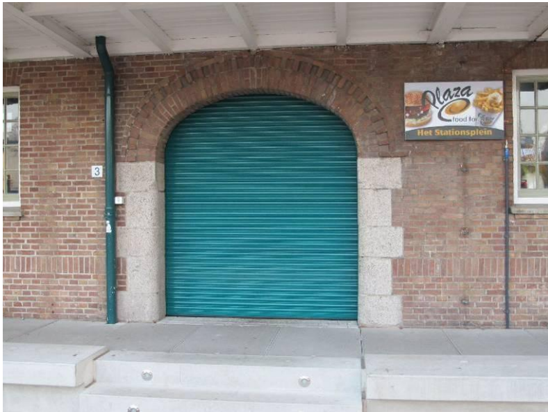
Oorspronkelijke dubbele deuropening goederenloods, met vernieuwde roldeur.
