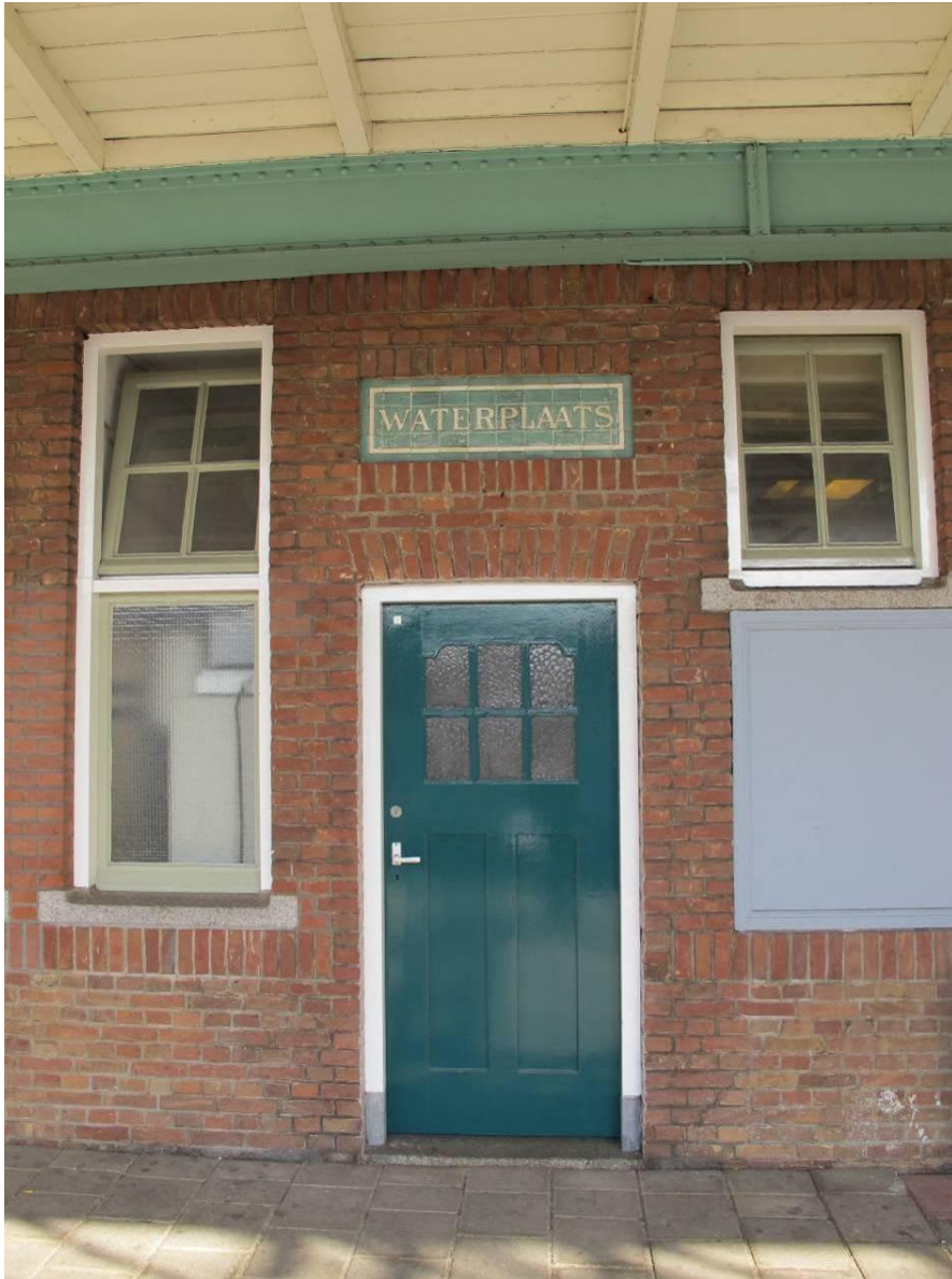
In de vroegere opening werd later een kozijn met deur geplaatst.
