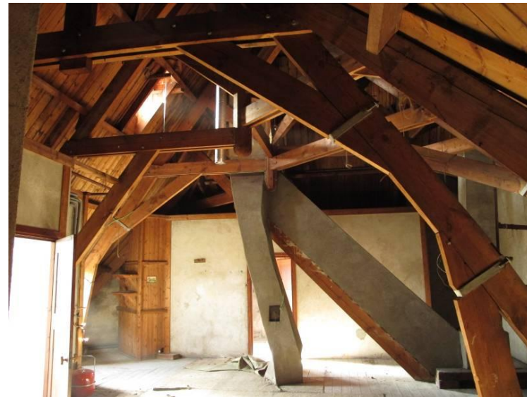
Zicht op de imposante kapconstructie met op de zolder aanwezige oorspronkelijke indeling (nr. 4)
