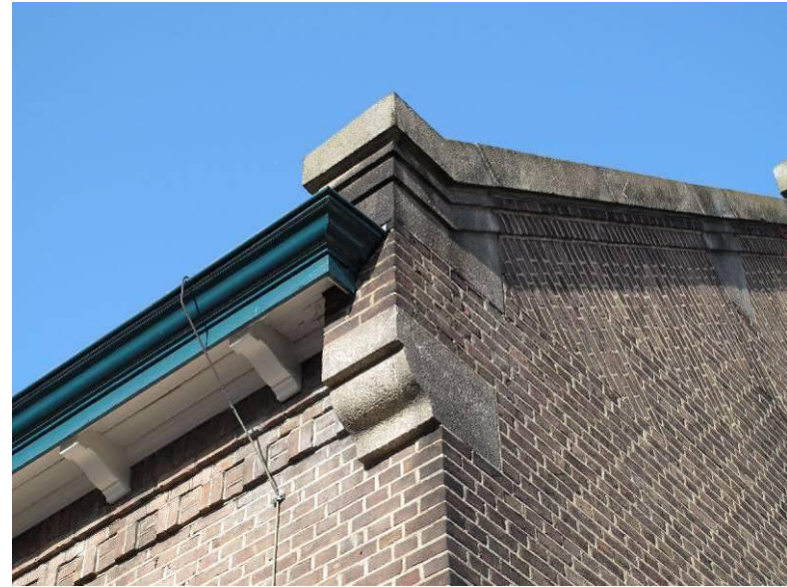
Detail verzorgd uitgevoerde aansluiting topgevel op geprofileerde goot op klossen.
