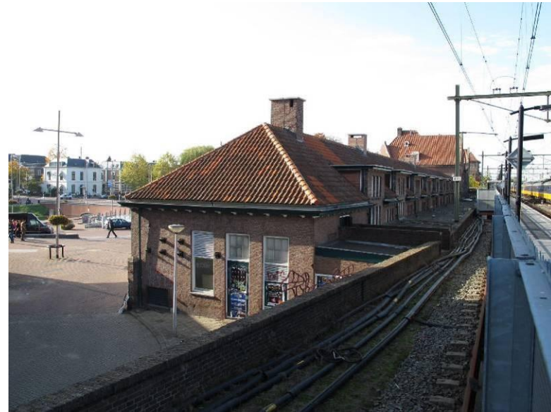
Overzicht oostgevel. Tussen het hoger gelegen spoor en de voorbouw ligt de overdekte gang, die aan deze zijde met een later toegevoegde gevel afsluit.
