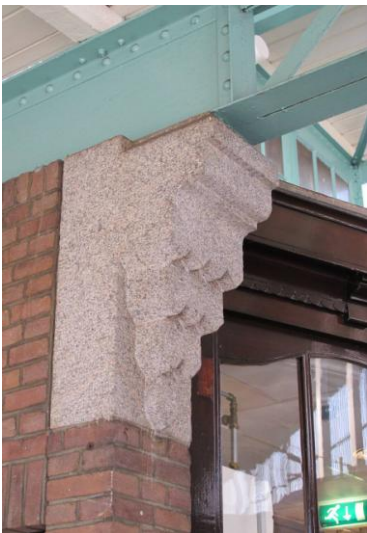
Detail bewerkte granieten console aan zuidzijde wachtkamergebouw.
