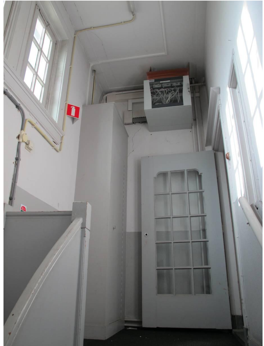
Aansluiting trappenhuis op de gang met nog vrijwel intacte historische detailleringen (nr. 6)
