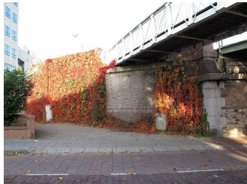
De zuidwestelijke keermuur, waarover in 1997 een voetgangersbrug werd gelegd.
