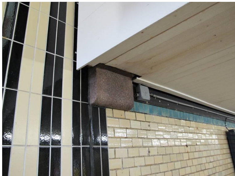
Detail wandtegels bij overgang op lagere plafondzone ter plaatse van spoorbaan. De linker tegels behoren bij de uitbreiding van 1985.
