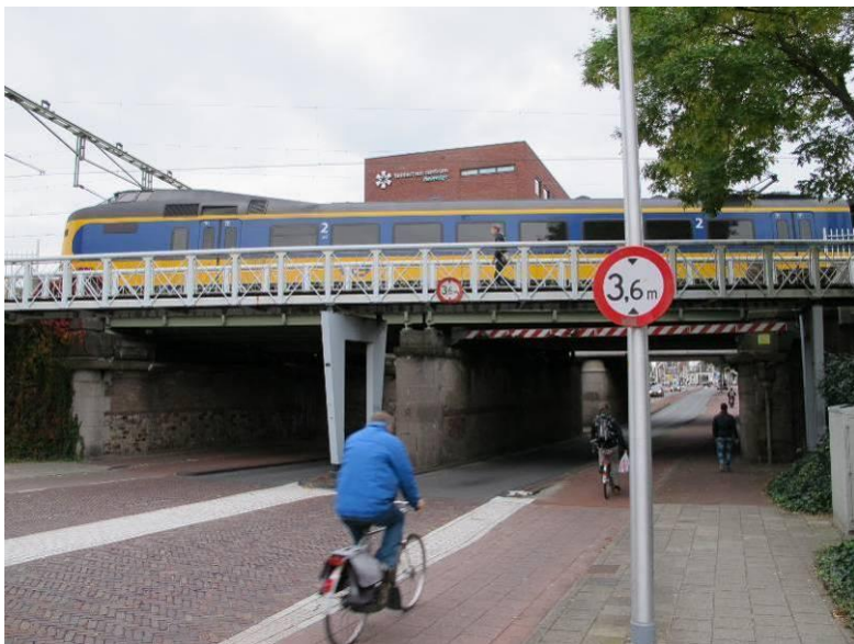
Overzicht viaduct vanaf de centrumzijde.
