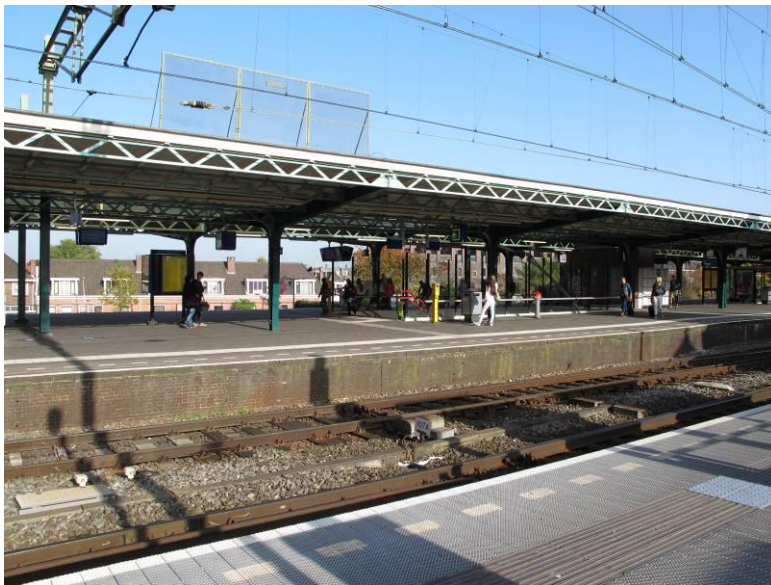
Aansluiting op persontunnel en gemetselde liftombouw.
