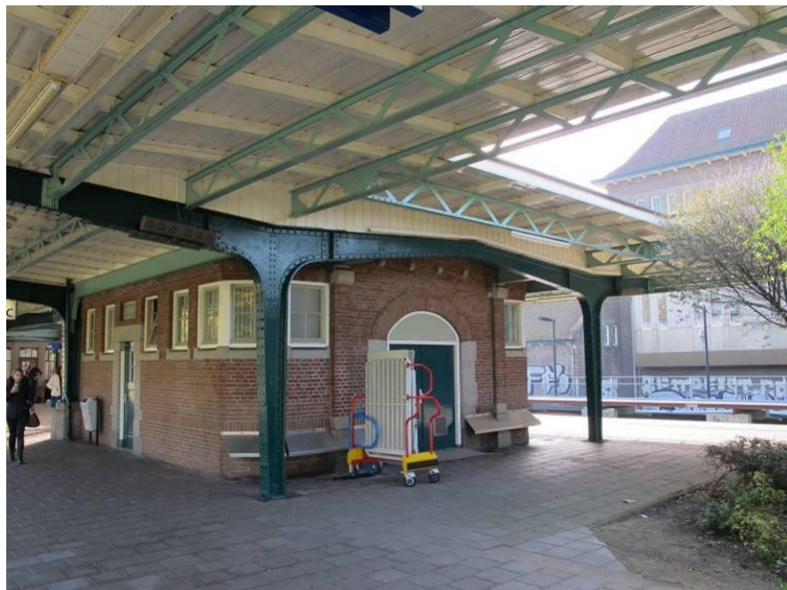
Overzicht toiletgebouwtje vanuit het noordwesten.
