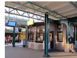
Kiosk in wachtkamer
