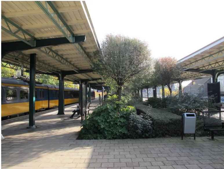
Dubbele kap ter plaatse van vroegere tongperrons bij westelijke deel perron.
