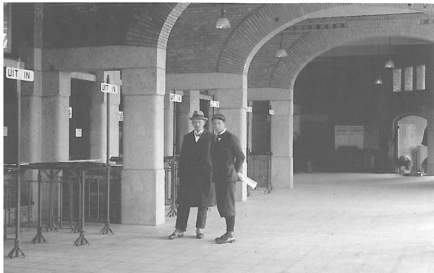
De stationshal tijdens de laatste werkzaamheden (bron: Van Zijl - glasnegatieven van J.W. Jansen sr. en jr)
