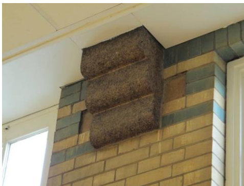
Detail granieten console onder plafondbalken.
