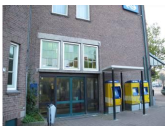
Nieuwe uitgang (buiten gebruik)
