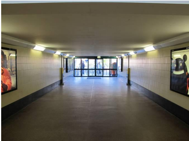
Zicht vanaf de perronzone richting stationhal (b) en richting uitgang aan de Diepenveenseweg (o).
