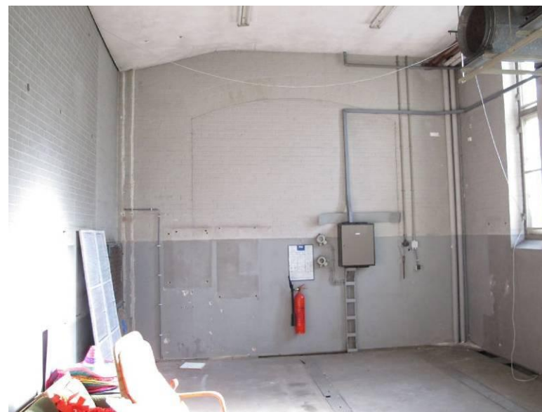
Dichtgemetselde vroegere doorgang tussen de watertoren en het ketelhuis.
