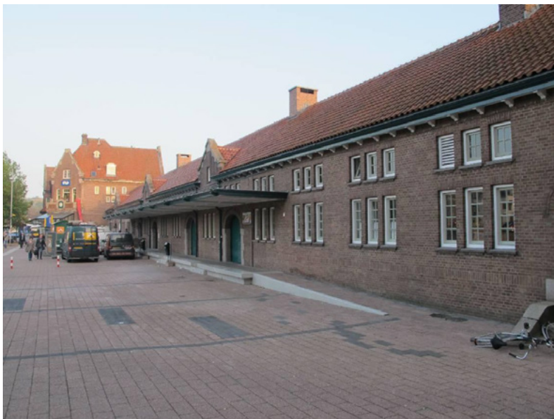
Overzicht rijwielstalling en goederengloods met op de achtergrond het stationsgebouw.
