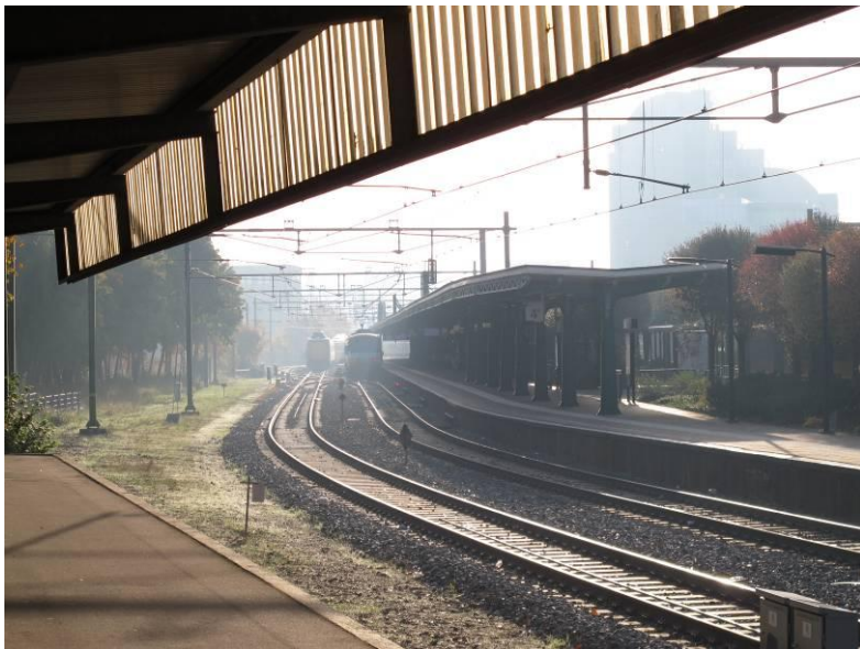
Overzicht van het eilandperron, vanaf het postperron.
