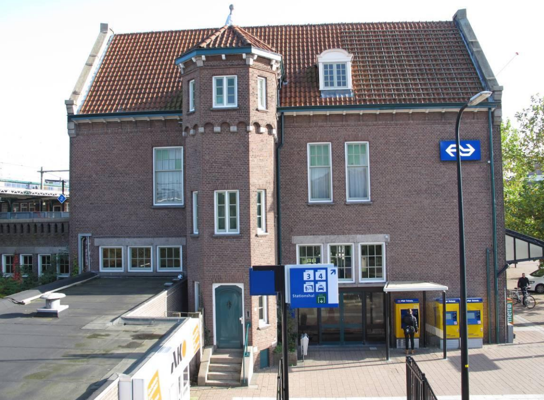
Overzicht linker zijgevel stationsgebouw.
