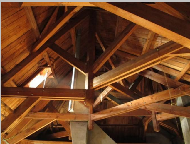
Historische constructies grotendeels bewaard gebleven
