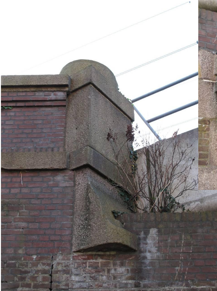
Detailering in graniet bij beëindiging gemetselde (deels vernieuwde) balustrade.
