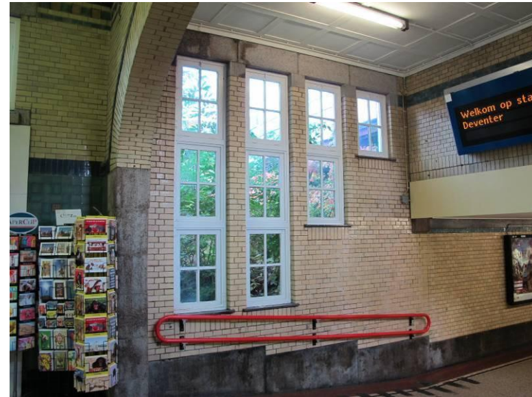
Westwand verbindingslid tussen stationshal en personentunnel.
