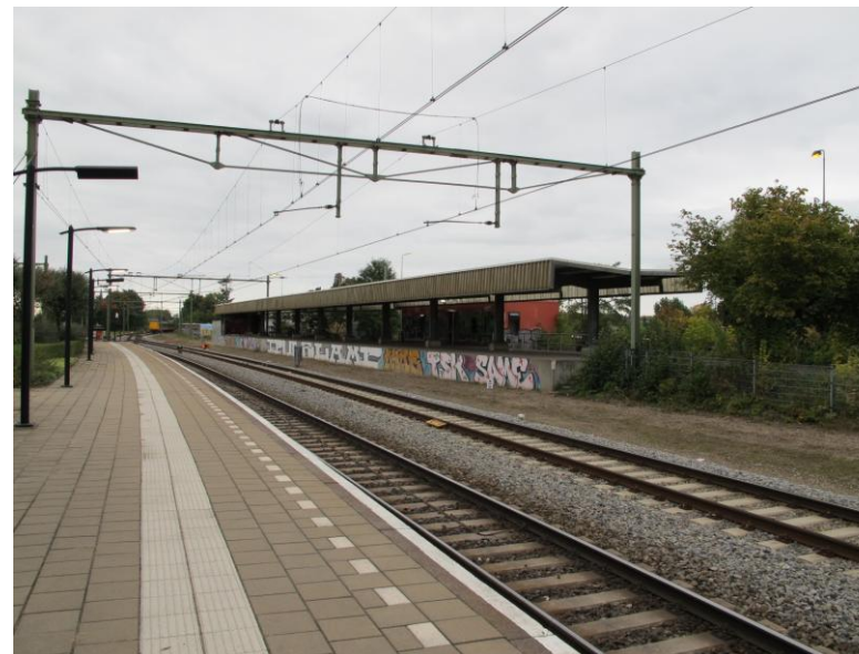
Overzicht van het postperron, gezien vanaf het eilandperron
