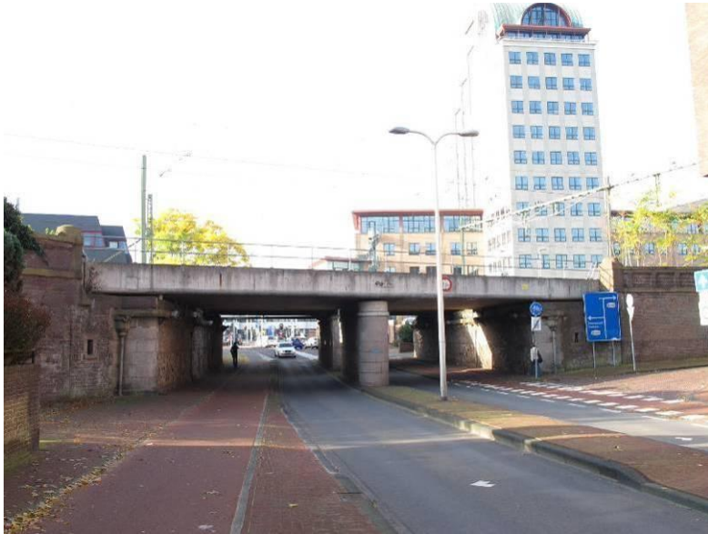
Overzicht viaduct vanaf de Brinkgreverweg.
