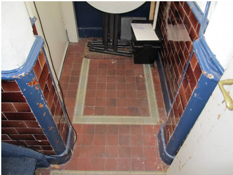
Detail tegelvloer en lambrisering bij entree bovenwoning
