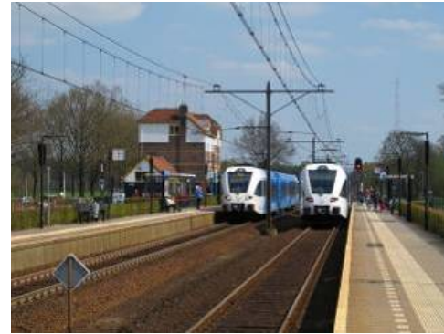
Spoorverdubbeling en opheffing eilandperron
