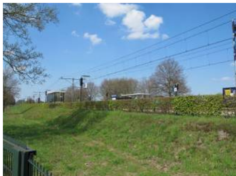
Verlegging perrons in westelijke richting
