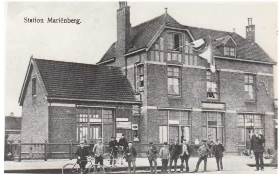
Het nog bestaande station Marienberg kwam in 1903 gereed. Dit station heeft aan beide zijden een aanbouw. Bron: stationsweb.nl
