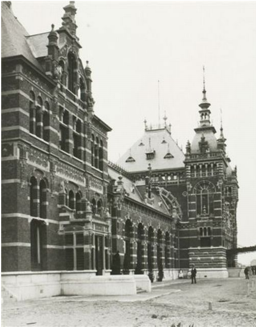
Station Den Bosch, omstreeks 1896. Dit zeer rijk gedetailleerde gebouw is de eerste grote opdracht van Cuypers. Het gebouw werd in 1944 verwoest. Bron: Stationsweb.nl
