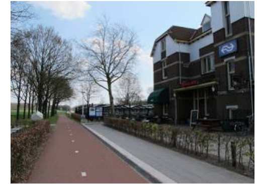
Verlegging weg en aanleg fietspad langs station
