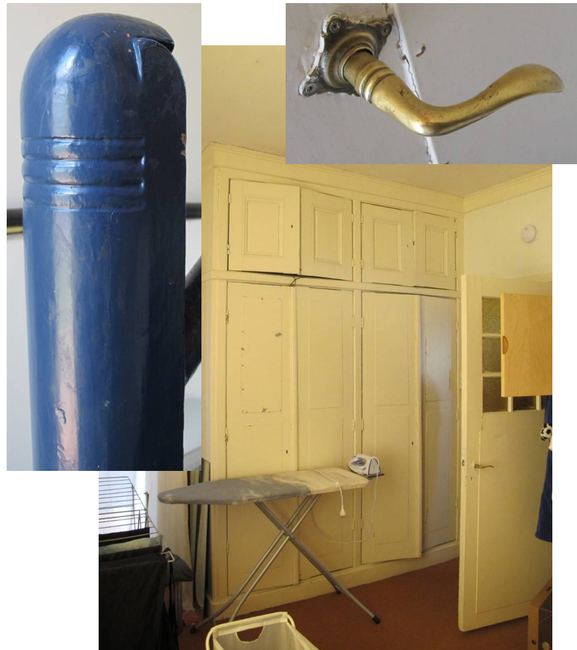
De vaste kasten tegen de westwand van de zuidoostelijke slaapkamer. Details van de bovenbeëindiging van de trapbaluster en een messing deurkruk.
