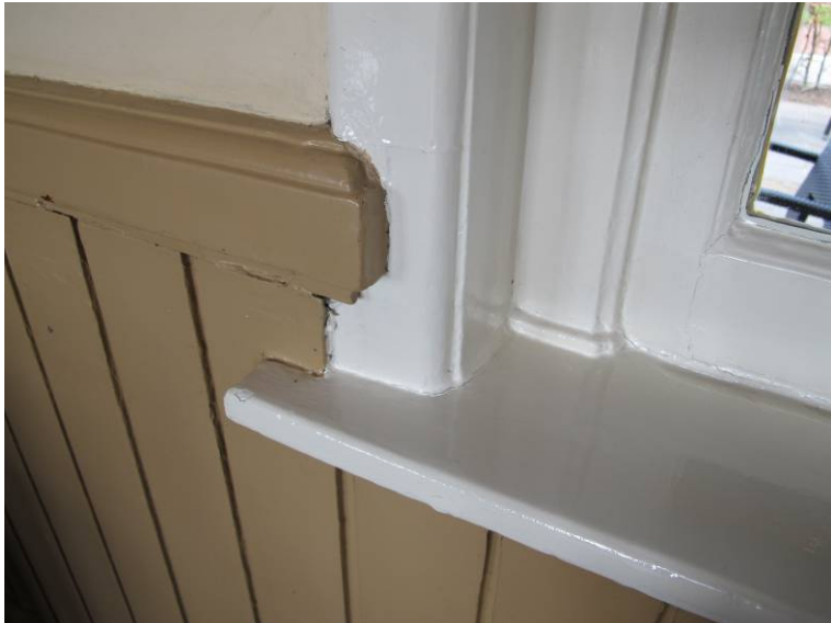
Detail aansluiting lambrisering op vensteromlijstingen.
