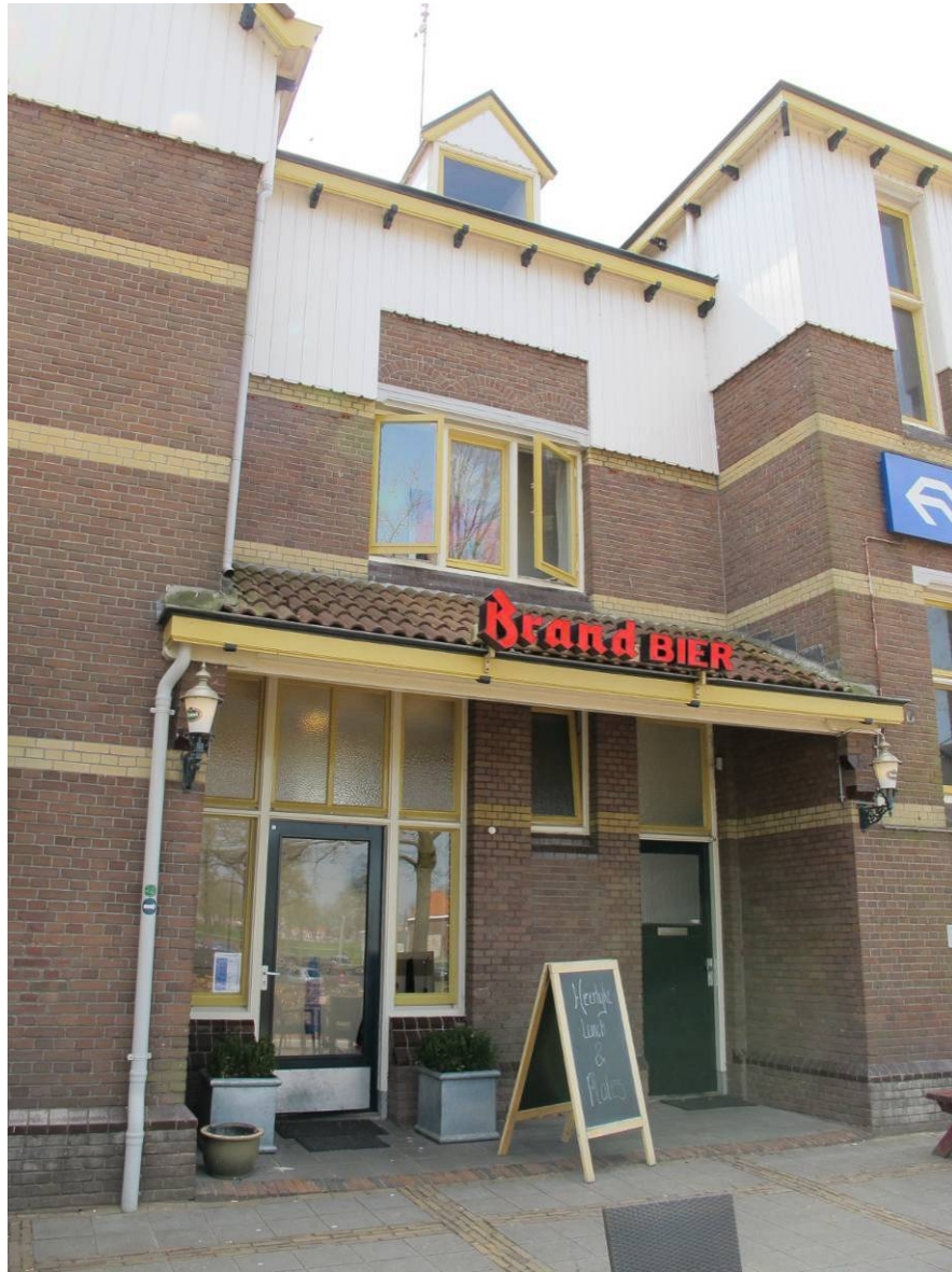
Luifel tegen de noordgevel met hieronder de oorspronkelijke toegang tot de stationsvestibule (links) en de toegang tot de bovenwoning (rechts)
