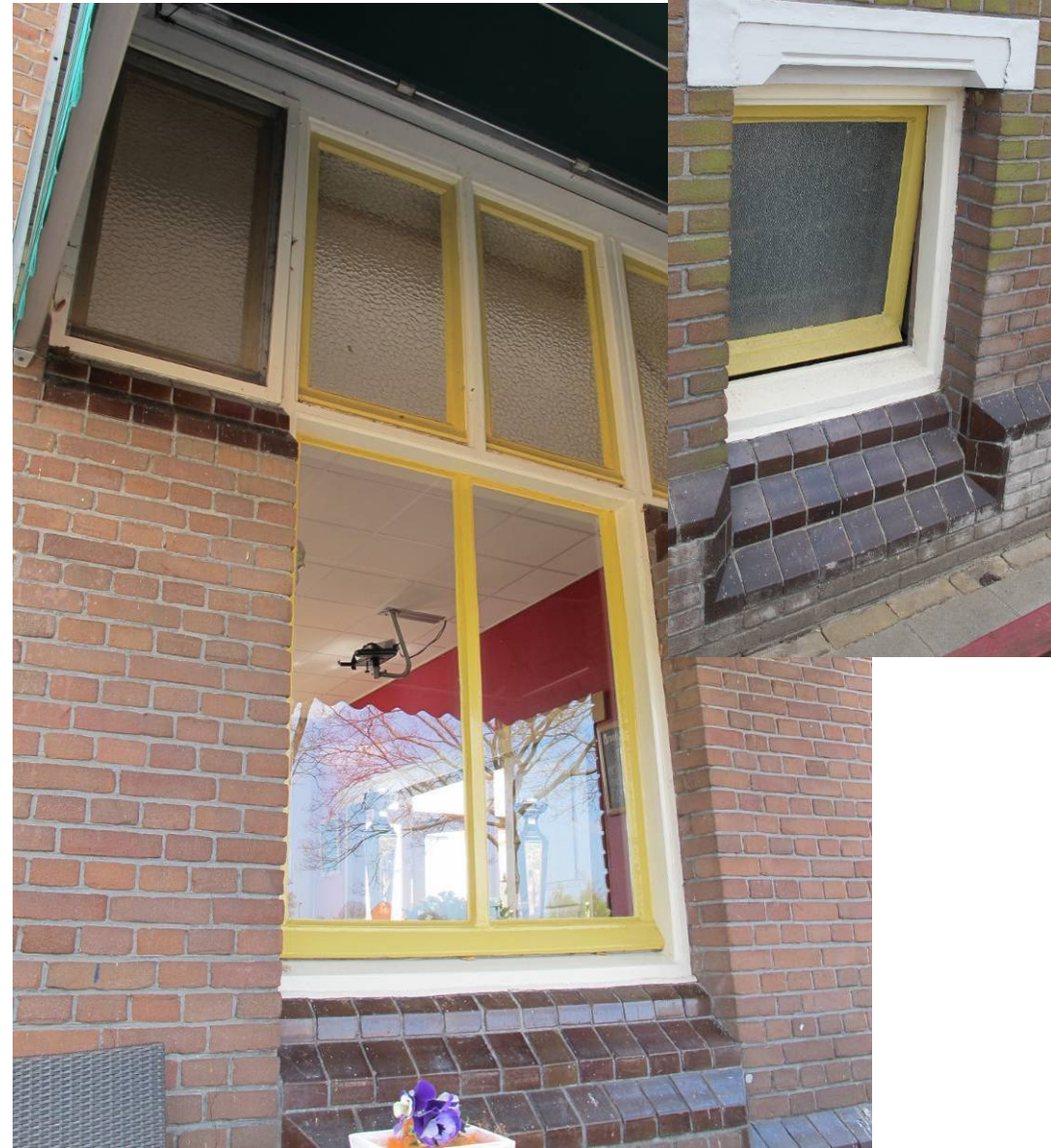
Overzicht van het venster, links in de noordgevel. Ook hier is de roedenverdeling van de bovenlichten verdwenen. Rechtsboven een detail van het in dezelfde gevel aanwezige kelderlicht.
