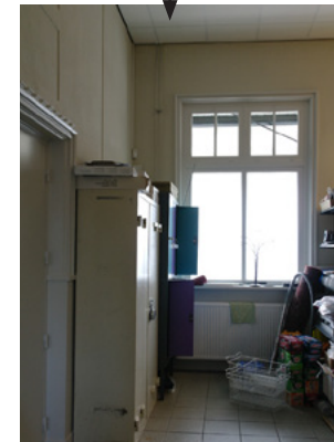
huidige situatie vm wachtkamer 1ste/2de klasse met verlaagd systeemplafond onder de oude kapconstructie en geschilderd houtwerk dat oorspoekelijk blank gelakt was
