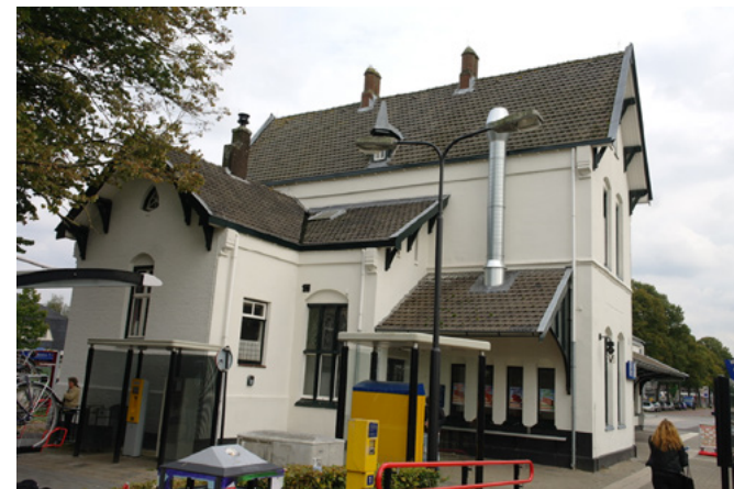
Afb. 1.29: huidige situatie recht zij(noord)gevel van het stationsgebouw, met afzuigkanaal cafetaria
