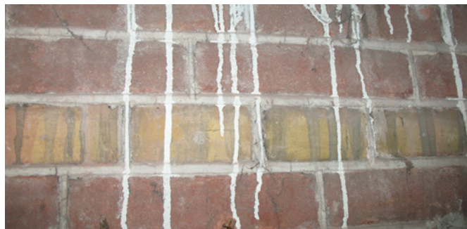
Afb. 4.25: Schoonmetselwerk in de vestibule
