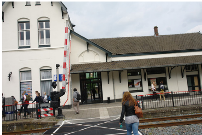
Afb. 1.28: huidige situatie achtergevel van het stationsgebouw, met nieuwe entreepui en doorgang naar het voorplein
