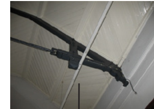
plafond met dakconstructie in wachtkamer vm 1ste/2de klasse (foto van vóór de verbouwing in 214); in 2014 is hier een verlaagd systeemplafond aangebracht
