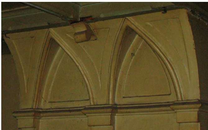
plafond en schoorsteen afwerking in vm kantoor, boven verlaagd plafond
