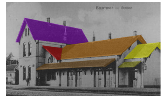
Afb. 4.2: Aanzicht westgevel (perronzijde)
