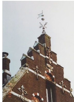
Afb. 0.1: In de oorspronkelijke situatie was het stationsgebouw van Boxmeer ongepleisterd, zoals hier te zien is bij station Kesteren
