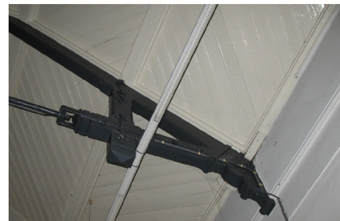
Afb. 4.26: Plafond met dakconstructie in vm 1e/2e klasse wachtkamer
