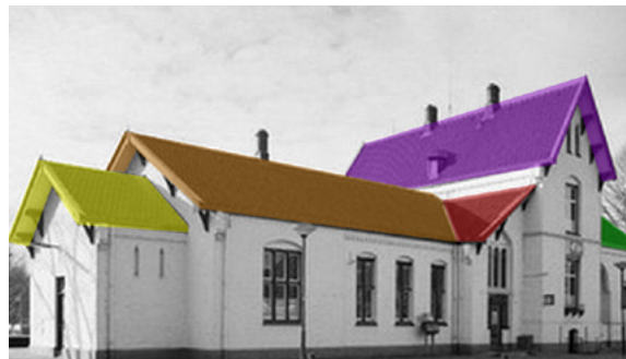
Afb. 4.1: Aanzicht oostgevel (voorzijde met aanduiding volumes)
