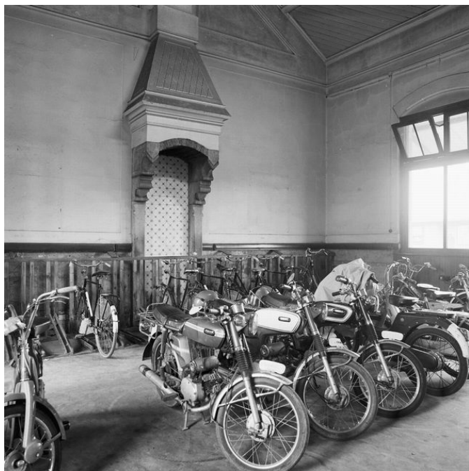
Afb. 4.28: Schouw met tegeltableau in station Venray, 1974
