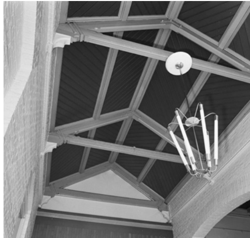
Afb. 4.7: Zadeldakconstructie in vestibule
