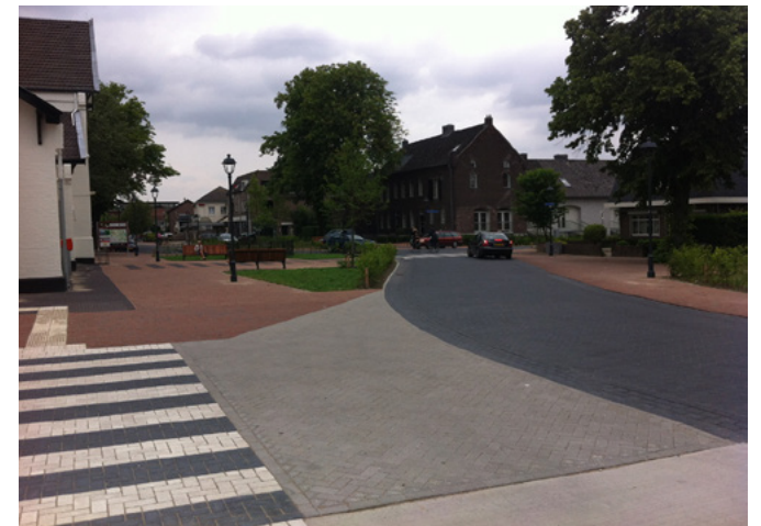
Afb. 3.20: Stationsweg vanuit het zuiden, vanaf de bussen, 2012
