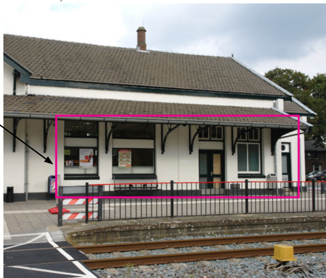
Afb. 4.45: achtergevel, de voormalige reizigersvleugel met de wachtkamers
