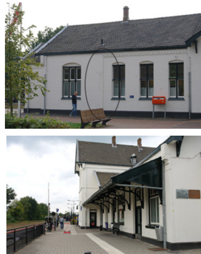
Afb. 4.21: boven gevel straatzijde, onder perronzijde
