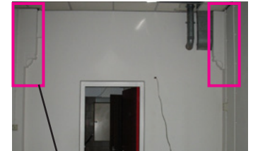
oorspronkelijke detaillering doorgang vm bagageafgifte (foto van vóór de verbouwing 2014)
