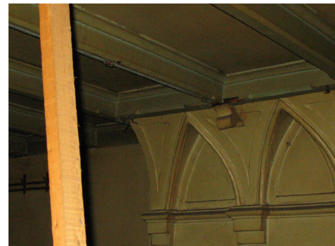
Afb. 4.27: Plafond in het voormalige kantoor
