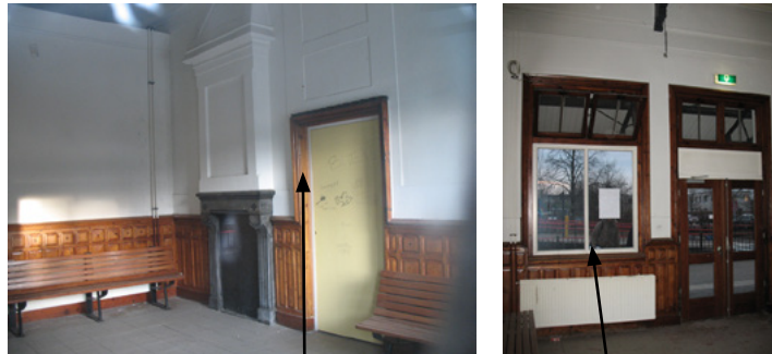
Afb. 4.48 en 4.49: wachtkamer 1ste / 2de klasse, voor de verbouwing / renovatie 2014
